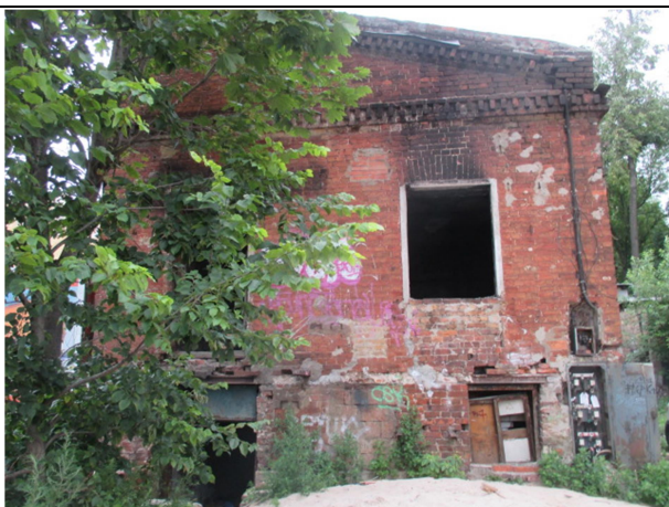
Фото № 7. Внешний вид здания
