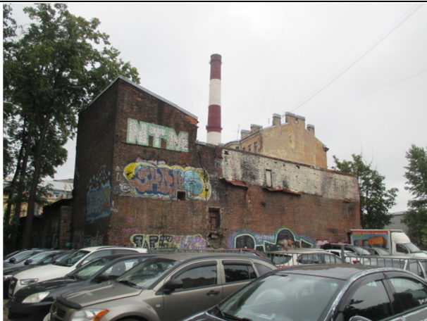
Фото № 5. Внешний вид здания
