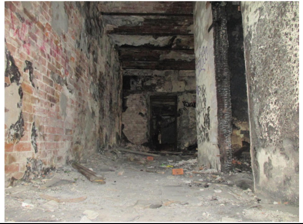
Фото № 10. Внутреннее состояние здания
