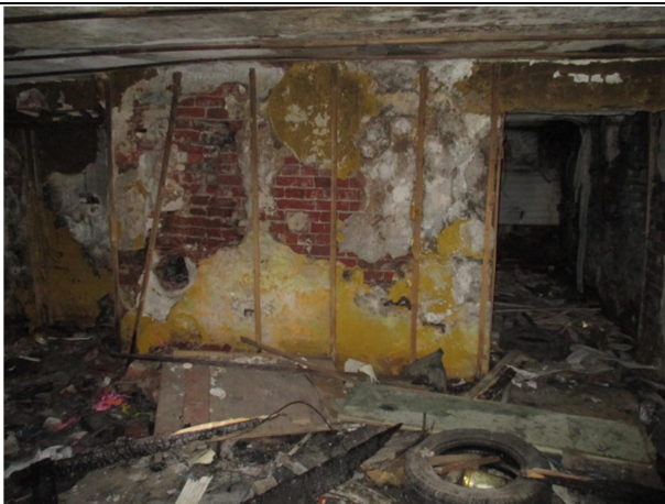
Фото № 13. Внутреннее состояние здания
