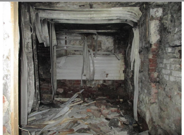
Фото № 14. Внутреннее состояние здания
