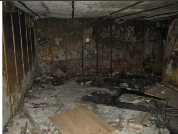
Фото № 12. Внутреннее состояние здания
