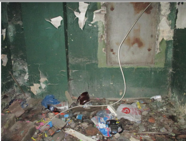
Фото № 15. Внутреннее состояние здания
