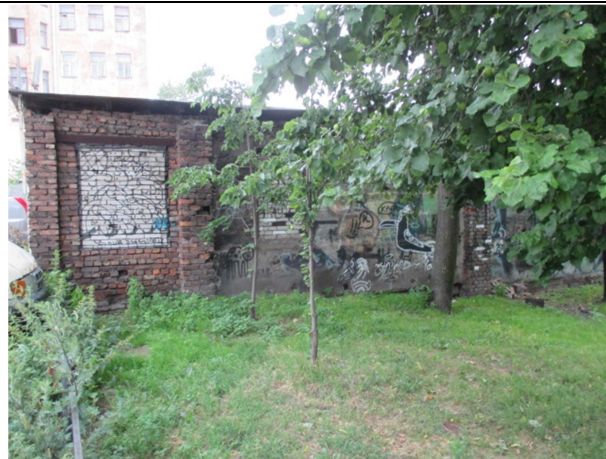
Фото № 2. Подъездные пути и окружение объекта
