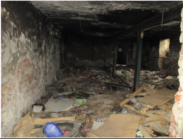
Фото № 9. Внутреннее состояние здания
