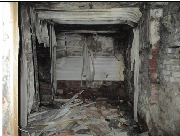
Фото № 14. Внутреннее состояние здания
