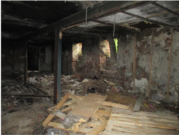
Фото № 11. Внутреннее состояние здания
