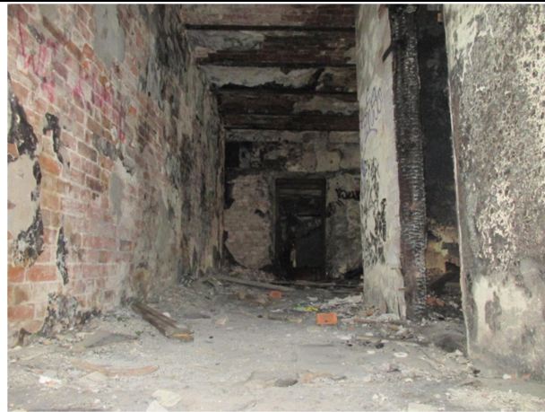
Фото № 10. Внутреннее состояние здания
