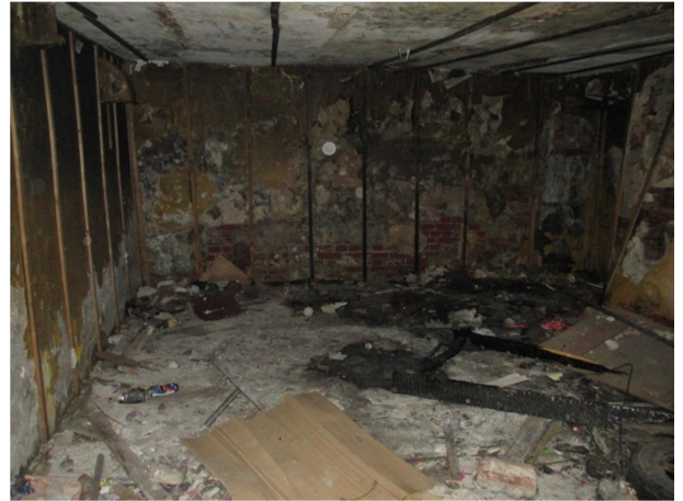
Фото № 12. Внутреннее состояние здания
