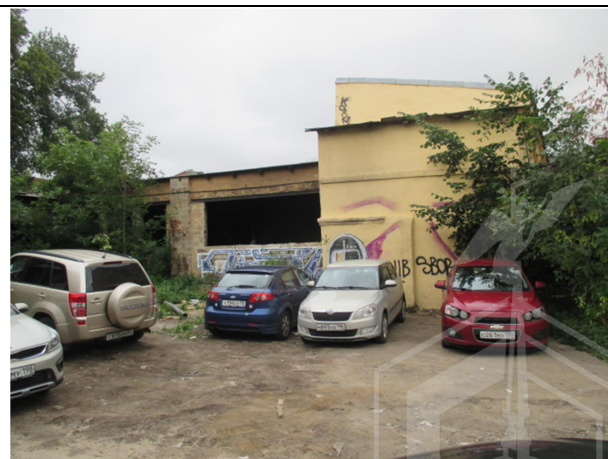
Фото № 8. Внешний вид здания
