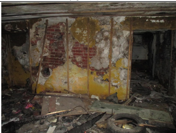
Фото № 13. Внутреннее состояние здания
