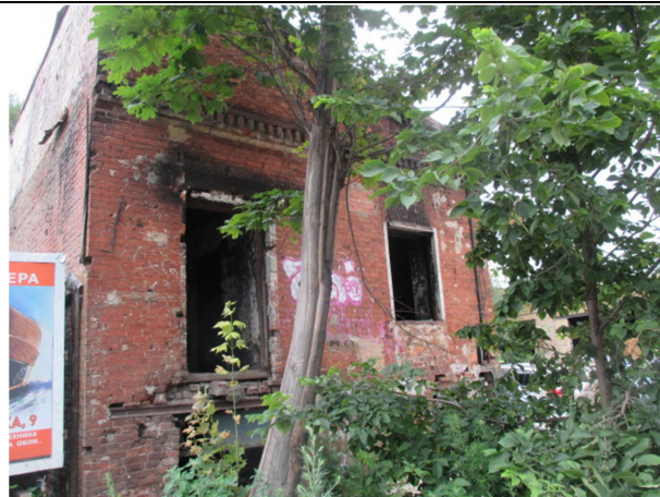
Фото № 6. Внешний вид здания
