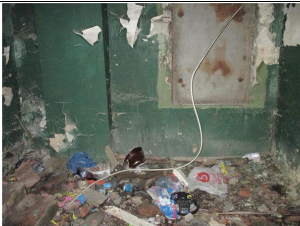
Фото № 15. Внутреннее состояние здания
