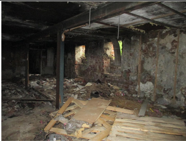
Фото № 11. Внутреннее состояние здания
