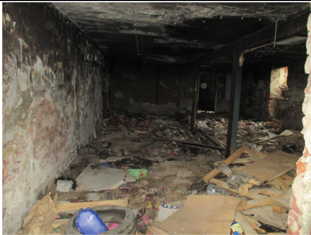
Фото № 9. Внутреннее состояние здания
