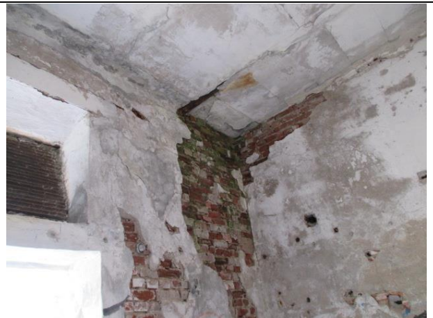
Фото № 10. Внутреннее состояние здания
