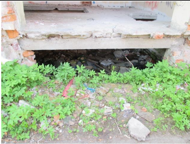
Фото № 15. Внутреннее состояние здания
