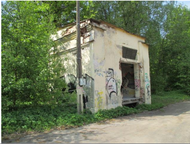
Фото № 5. Внешний вид здания
