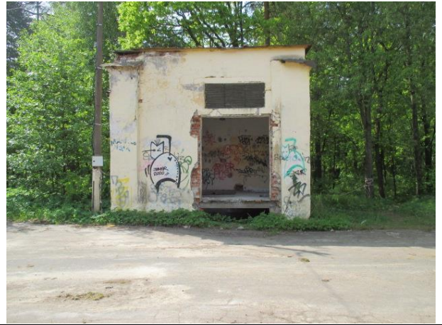
Фото № 6. Внешний вид здания
