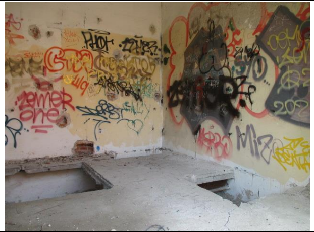
Фото № 14. Внутреннее состояние здания
