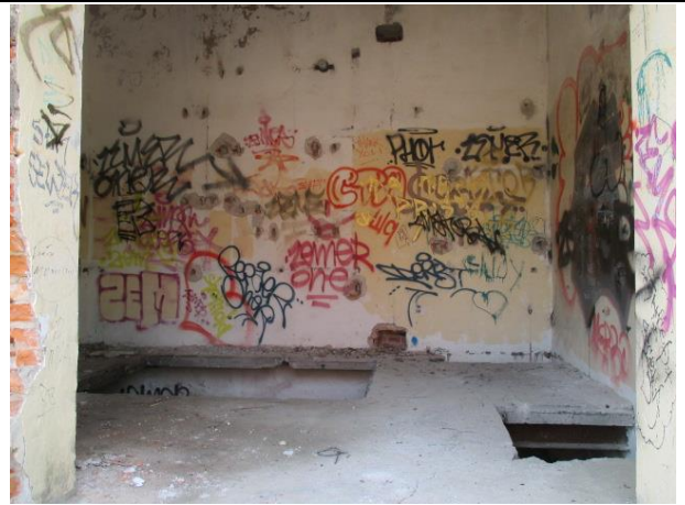
Фото № 16. Внутреннее состояние здания
