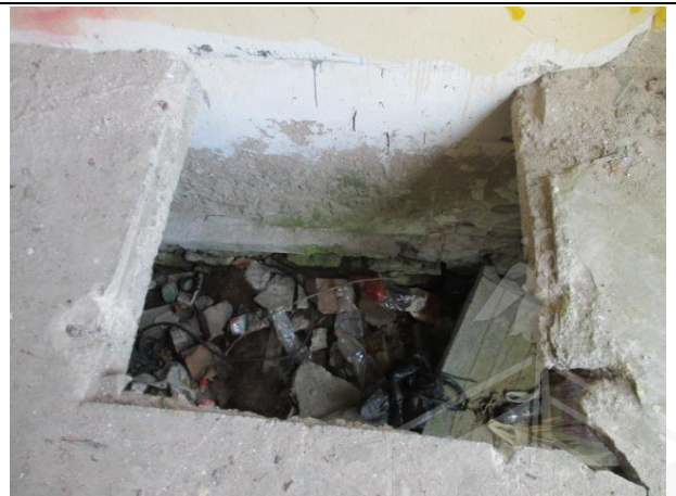
Фото № 12. Внутреннее состояние здания
