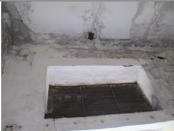
Фото № 9. Внутреннее состояние здания
