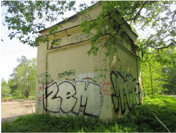
Фото № 7. Внешний вид здания
