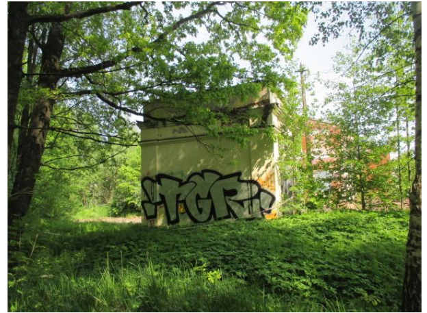
Фото № 8. Внешний вид здания
