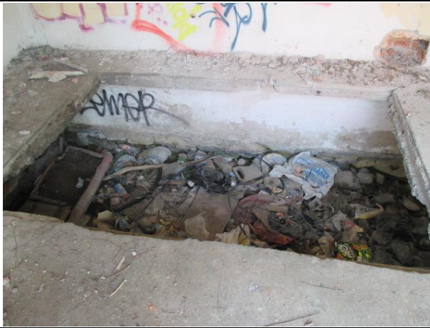
Фото № 13. Внутреннее состояние здания
