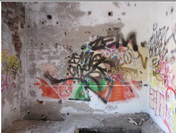
Фото № 11. Внутреннее состояние здания
