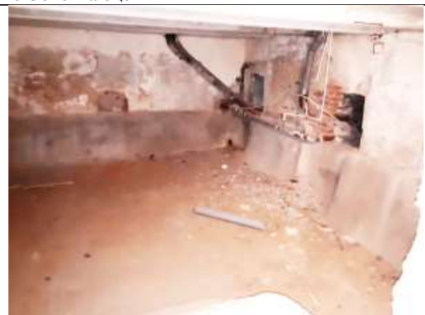
Фото 10. Внутреннее состояние Объекта оценки
