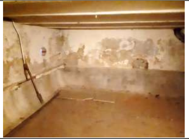
Фото 12. Внутреннее состояние Объекта оценки
