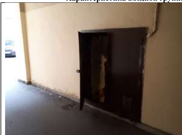
Фото 7. Отдельный вход со двора (из арки, низкий)
