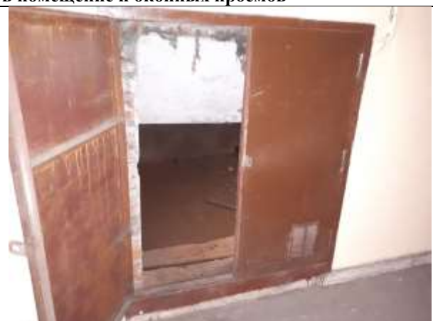
Фото 8. Отдельный вход со двора (из арки, низкий)
