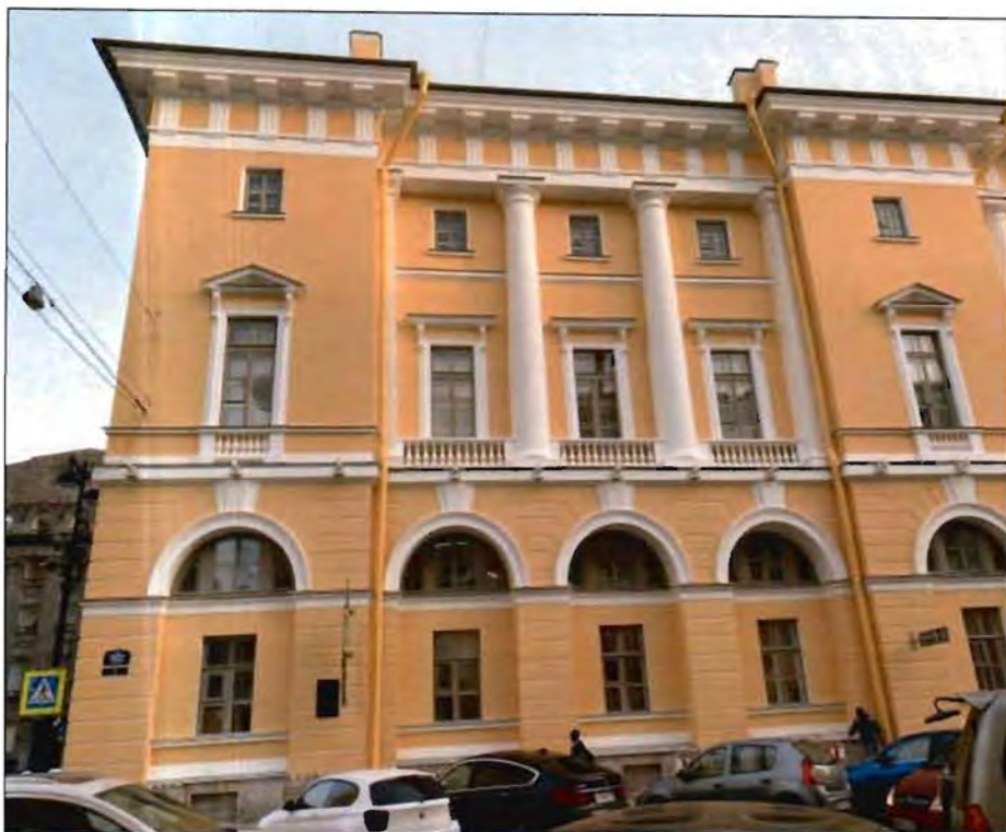
5. Фрагмент западного фасада. Фото от 09.11.2021 г.
