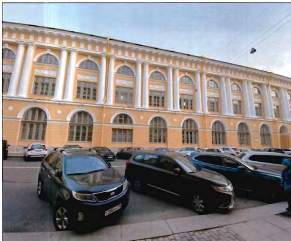
6. Фрагмент западного фасада. Фото от 09.11.2021 г.
