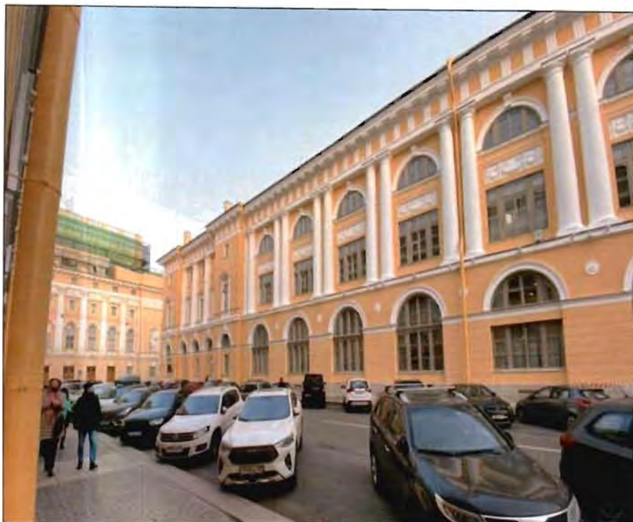
3. Общий вид на западный фасад со стороны ул. Зодчего Росси. Фото от 09.11.2021 г.
