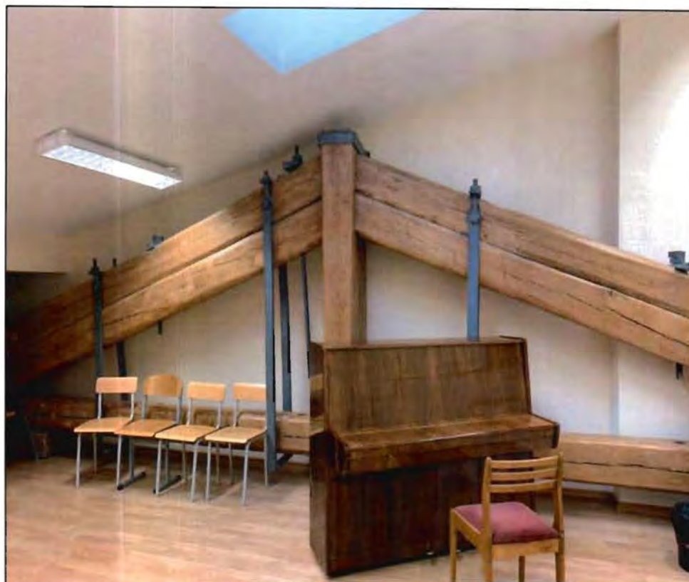
25. Фрагмент исторической стропильной системы. Фото от 09.11.2021 г.
