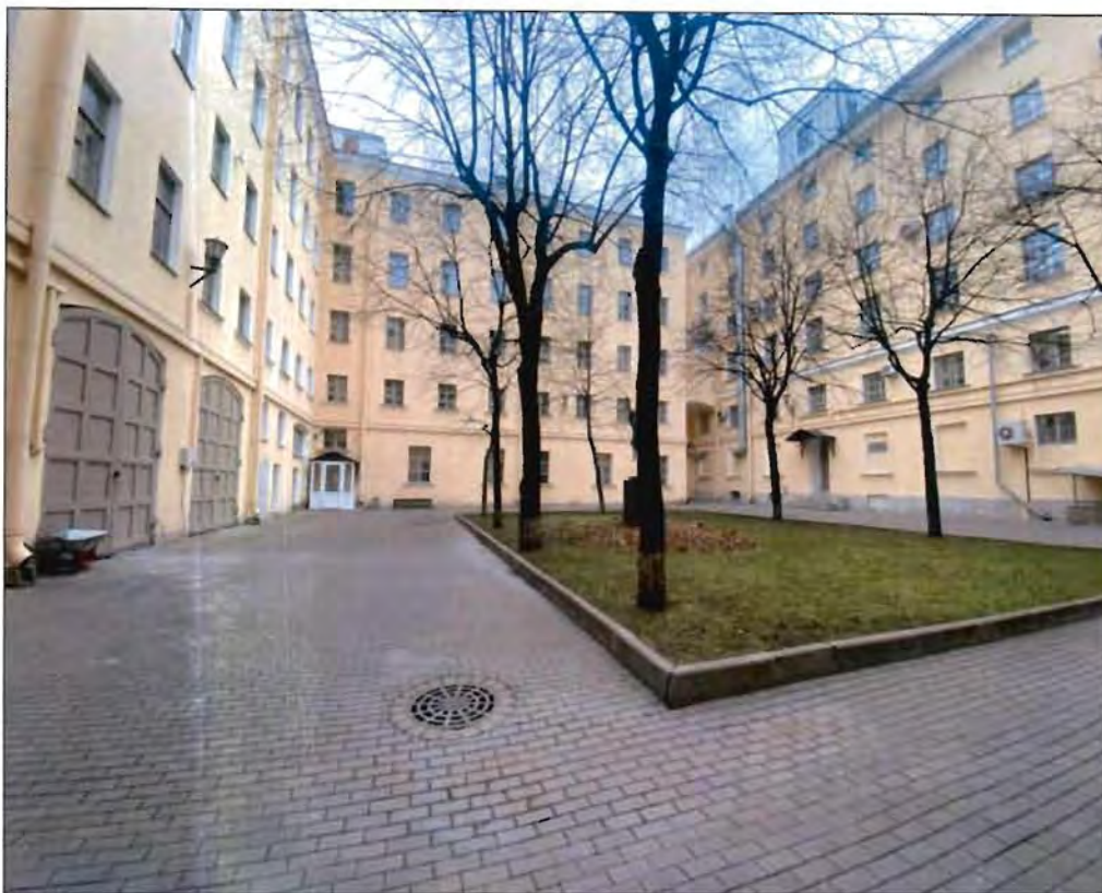
11. Дворовые фасады южного внутреннего двора. Фото от 09.11.2021 г.
