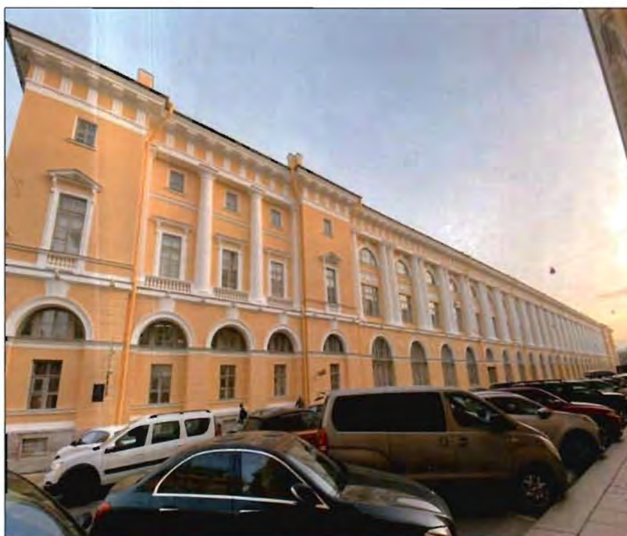
4. Общий вид на западный фасад со стороны ул. Зодчего Росси. Фото от 09.11.2021 г.
