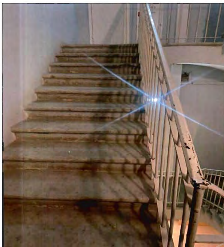
32. Двухмаршевая лестница с известняковыми ступенями. Фото от 10.11.2021 г.
