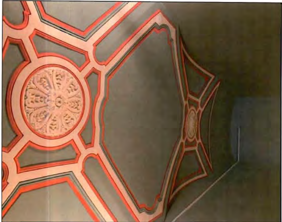
23. Фигурные филенки в профилированных рамах, объединенные в центре фигурной профилированной рамой с вписанной круглой лепной розеткой с растительным орнаментом в оформлении потолка лестничного объема в южной части южного лицевого корпуса по ул. Зодчего Росси. Фото от 09.11.2021 г.
