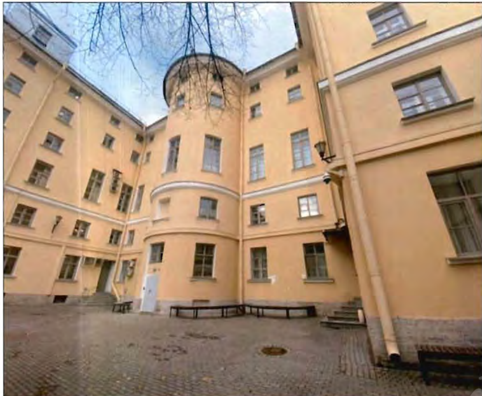
14. Дворовые фасады северного внутреннего двора. Фото от 09.11.2021 г.
