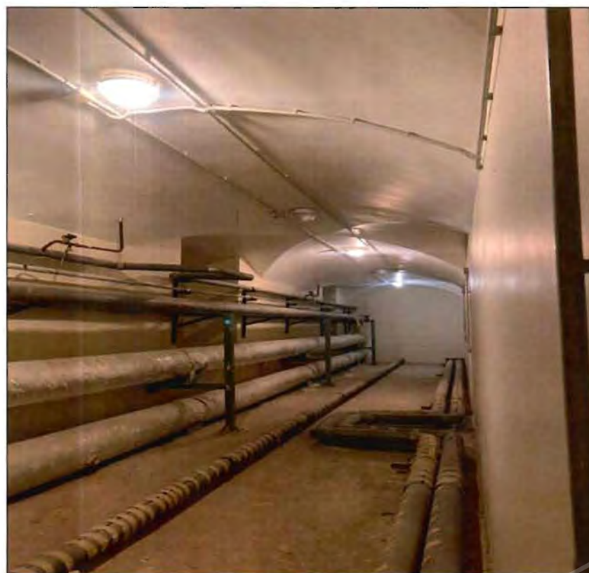
28. Сводчатые перекрытия в уровне подвала. Фото от 09.11.2021 г.
