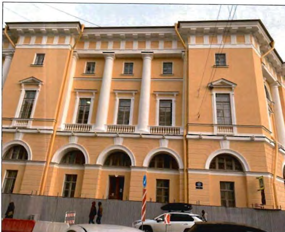
7. Фрагмент западного фасада. Фото от 09.11.2021 г.
