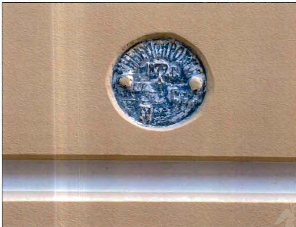
10. Исторический геодезический знак (металл, изображение, нивелировка, 1872 г.), размещенный со стороны лицевого фасада по улице Зодчего Росси. Фото от 09.11.2021 г.
