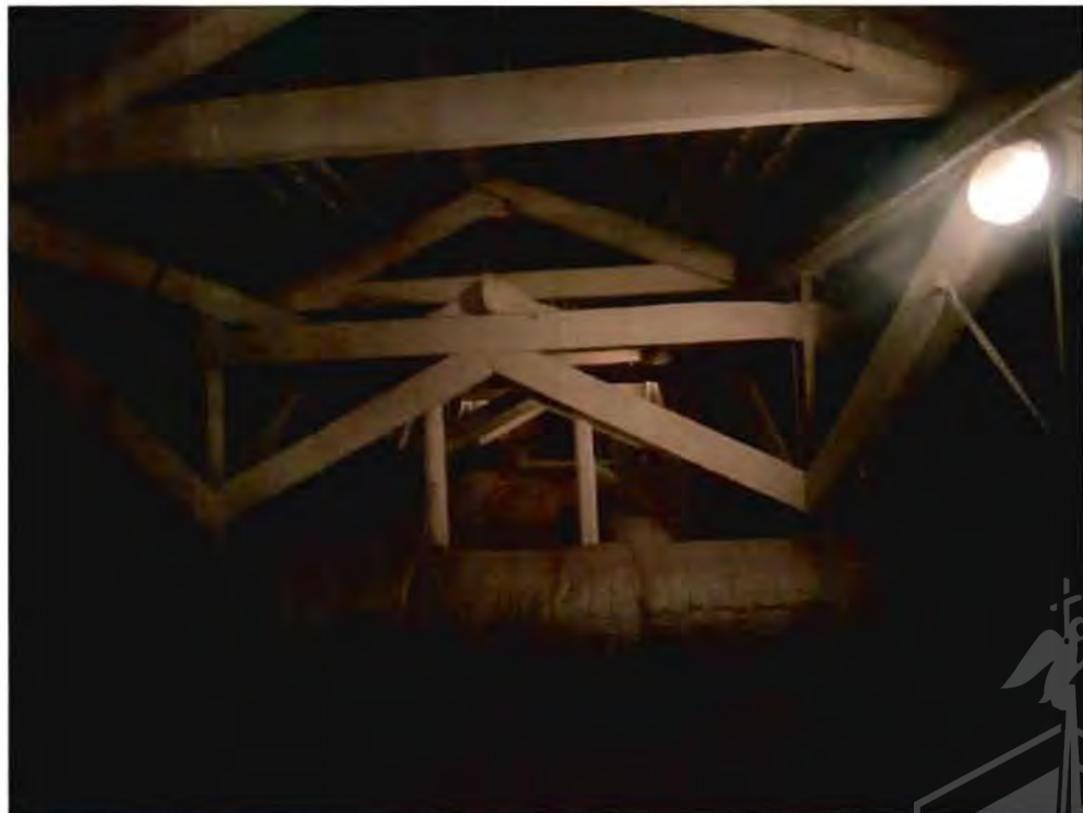
24. Фрагмент стропильной системы. Фото от 09.11.2021 г.
