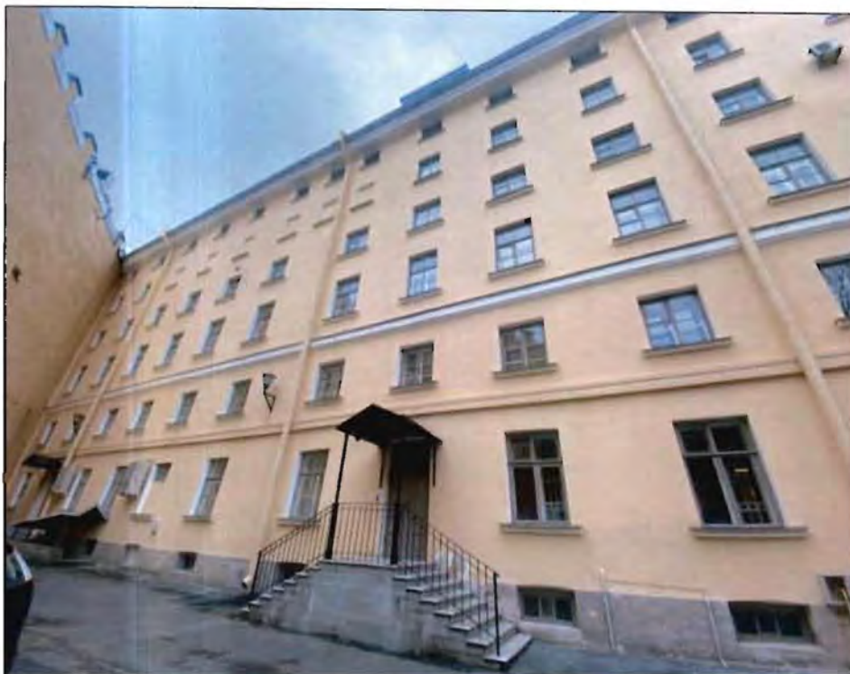
15. Западный дворовый фасад. Дополнительное инженерное оборудование на фасаде. Фото от 09.11.2021 г.
