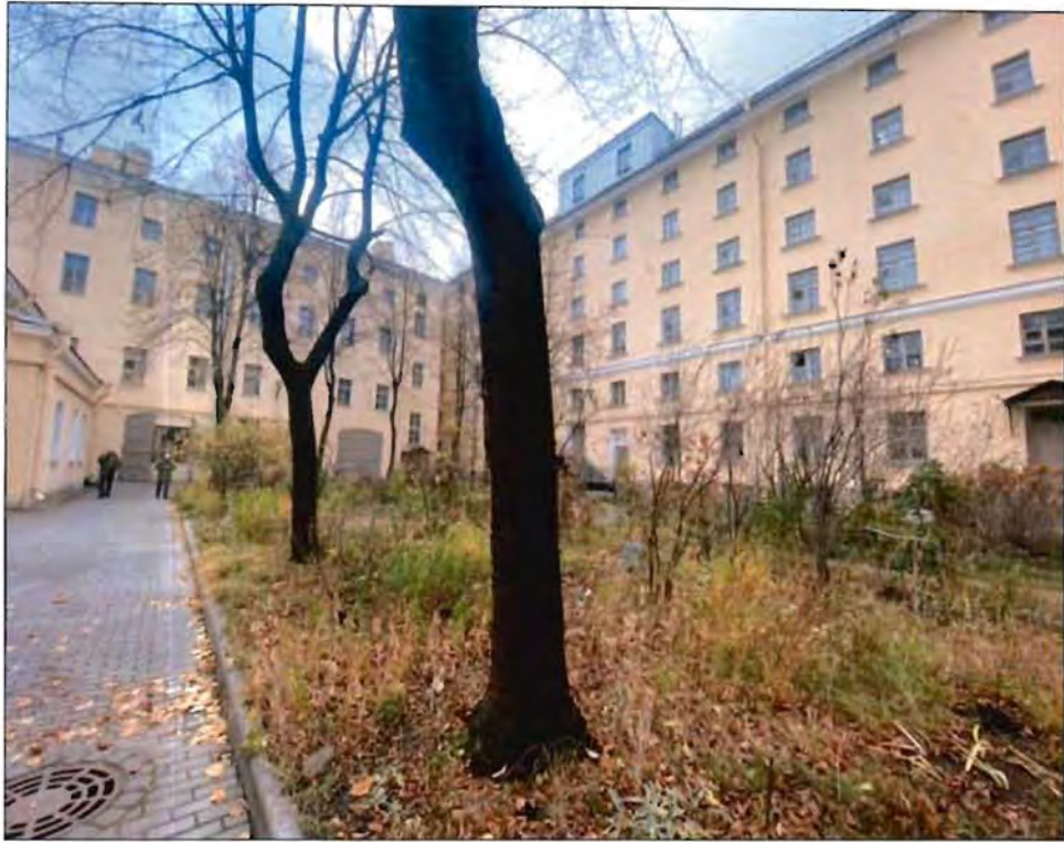
13. Дворовые фасады северного внутреннего двора. Фото от 09.11.2021 г.
