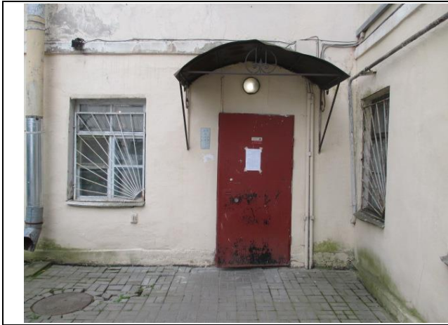
Фото № 7. Вход в помещение
