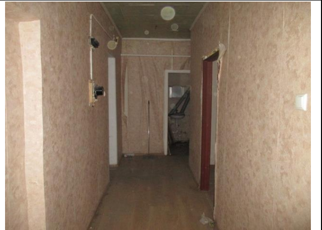
Фото № 10. Внутреннее состояние помещения
