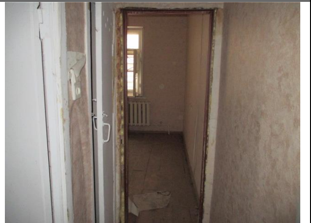
Фото № 12. Внутреннее состояние помещения
