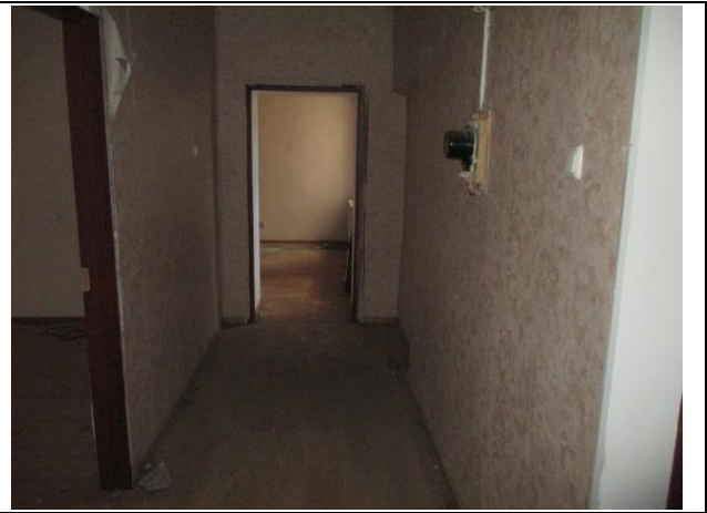
Фото № 8. Внутреннее состояние помещения
