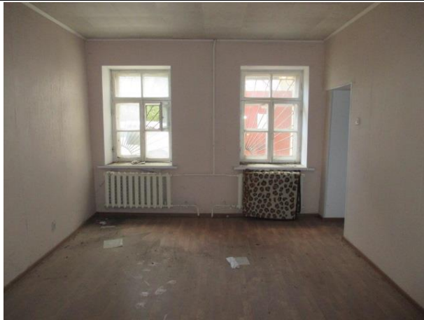
Фото № 9. Внутреннее состояние помещения
