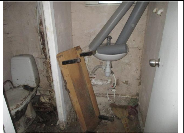
Фото № 16. Внутреннее состояние помещения
