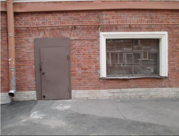
Фото № 7 – Вход в помещение со двора
