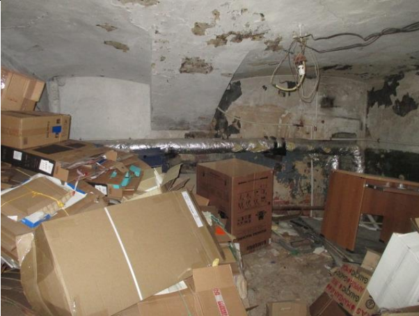
Фото № 9 – Внутреннее состояние помещения
