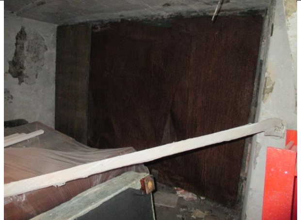
Фото № 10 – Внутреннее состояние помещения
