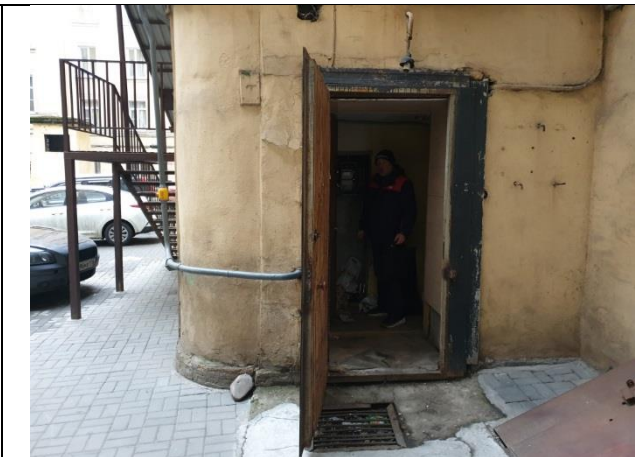
Фото № 6 – Вход в помещение
