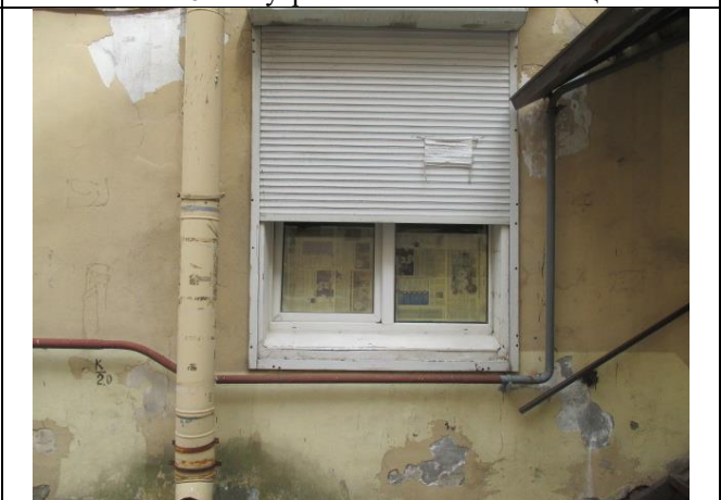
Фото № 18 – Окно в помещении
