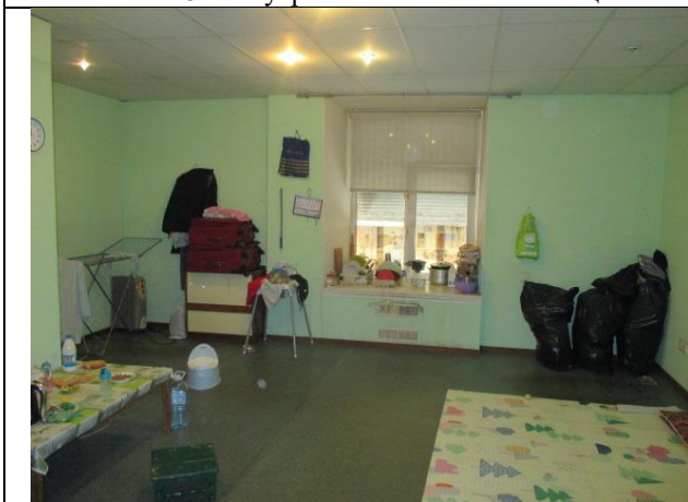
Фото № 17 – Внутреннее состояние помещения
