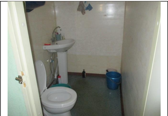
Фото № 14 – Внутреннее состояние помещения
