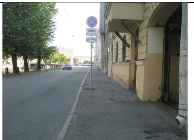
Фото № 2 – Подъездные пути
