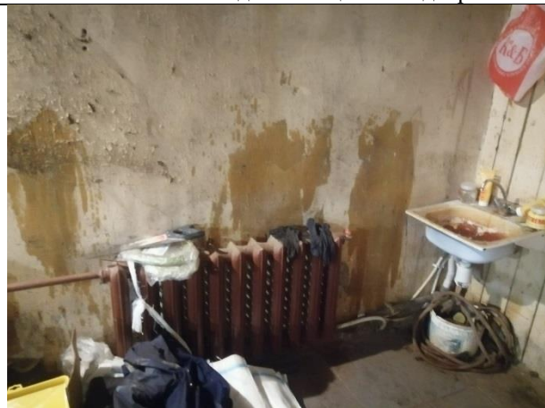
Фото № 10 – Внутреннее состояние помещения
