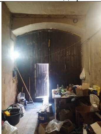
Фото № 9 – Внутреннее состояние помещения
