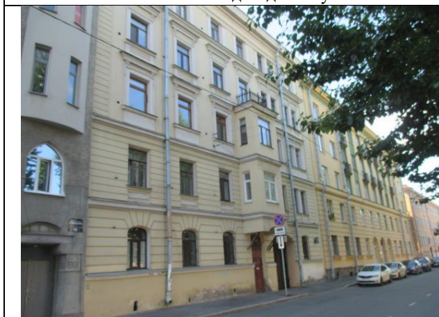
Фото № 3 – Вид здания
