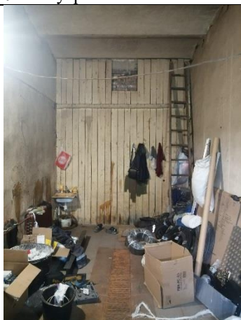
Фото № 11 – Внутреннее состояние помещения
