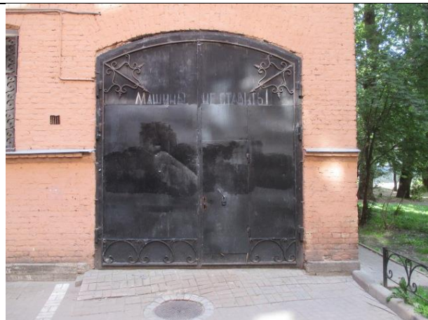
Фото № 8 – Вход в помещение со двора
