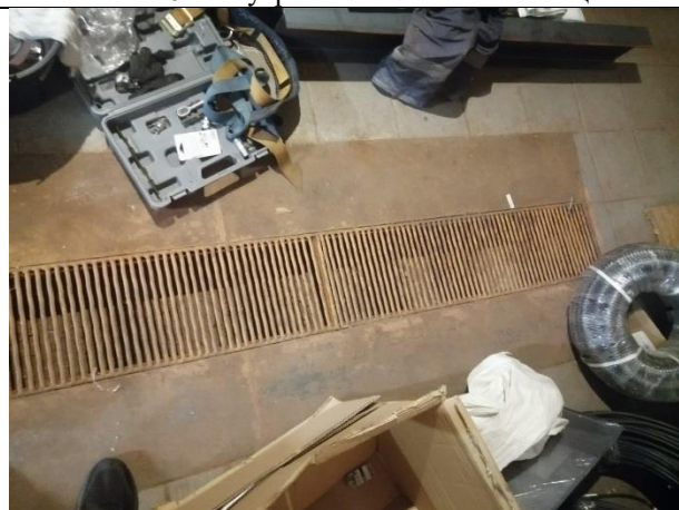
Фото № 12 – Внутреннее состояние помещения
