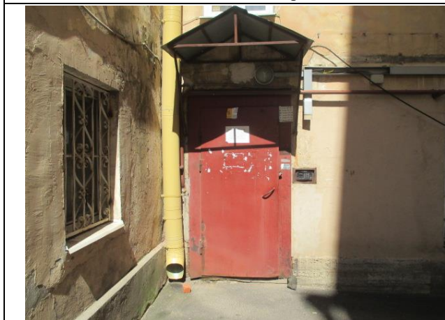
Фото № 5. Вход в помещение
