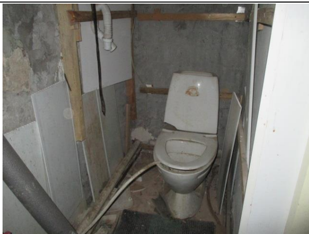
Фото № 13. Внутреннее состояние помещения
