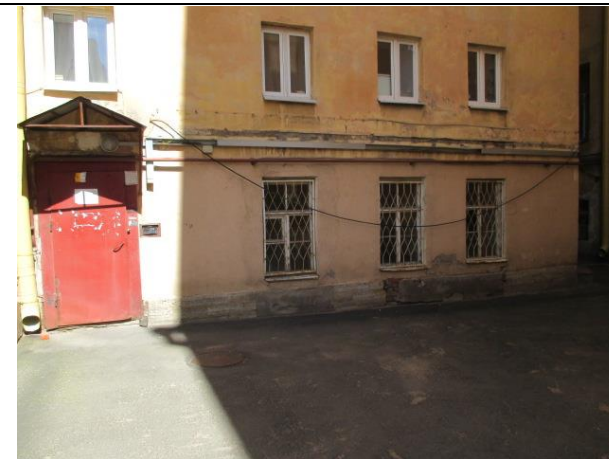
Фото № 4. Вход в помещение
