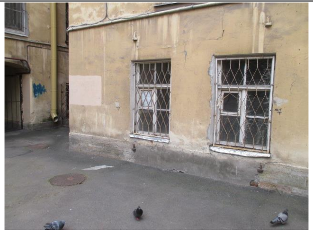
Фото № 18. Окна помещения
