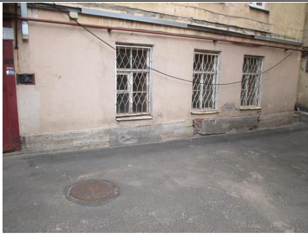
Фото № 17. Окна помещения
