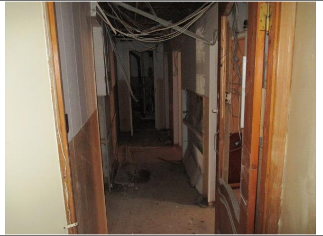
Фото № 8. Внутреннее состояние помещения
