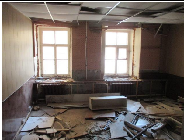
Фото № 9. Внутреннее состояние помещения
