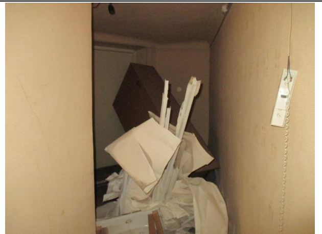
Фото № 10. Внутреннее состояние помещения
