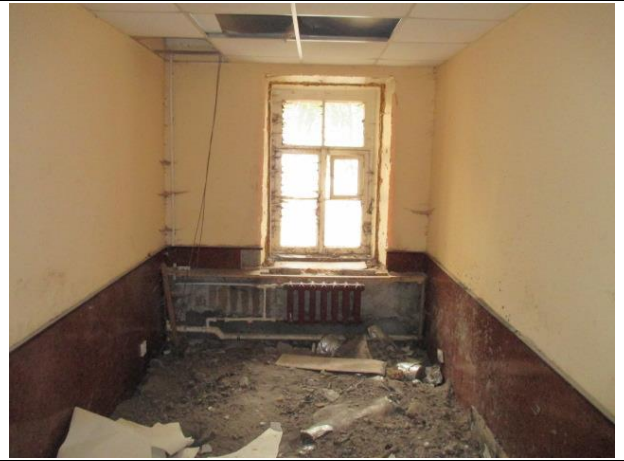
Фото № 16. Внутреннее состояние помещения
