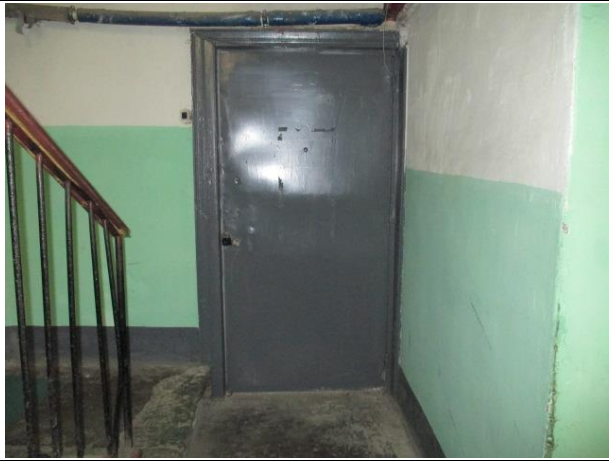
Фото № 7. Вход в помещение
