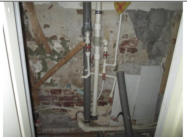
Фото № 12. Внутреннее состояние помещения
