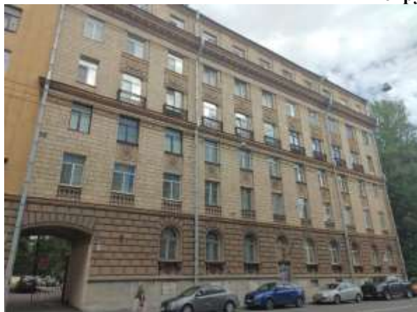
Фото 1. Вид здания Объекта оценки, с улицы
