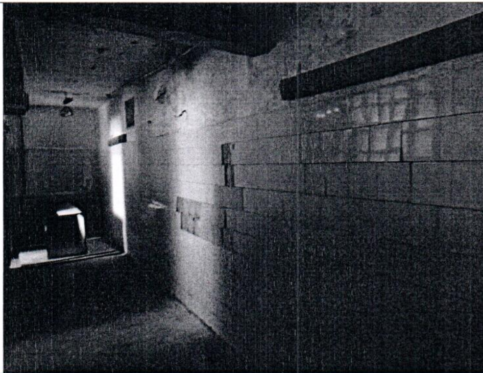
Описание: Вид внутри Объекта (пом. 8-Н (ч.п. 2))
