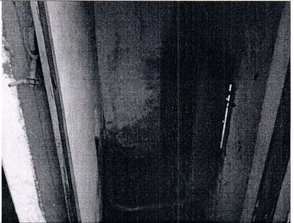
Описание: Вид внутри Объекта (пом. 11-Н)
