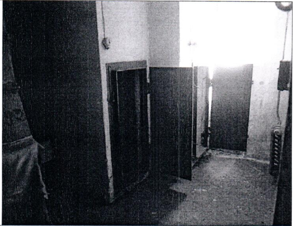
Описание: Вид внутри Объекта (пом. 11-Н)
