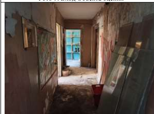
Фото 11. Внутреннее состояние Объекта оценки
