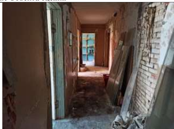
Фото 10. Внутреннее состояние Объекта оценки
