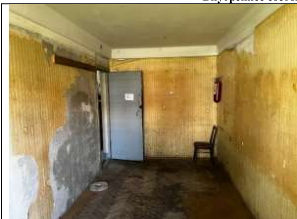
Фото 9. Внутреннее состояние Объекта оценки
