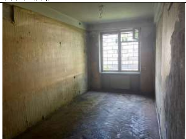
Фото 10. Внутреннее состояние Объекта оценки
