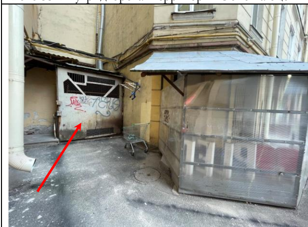
Фото 35. Вид здания расположения Объекта оценки
