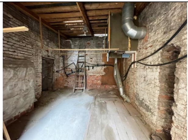
Фото 38. Типичное состояние Объекта оценки
