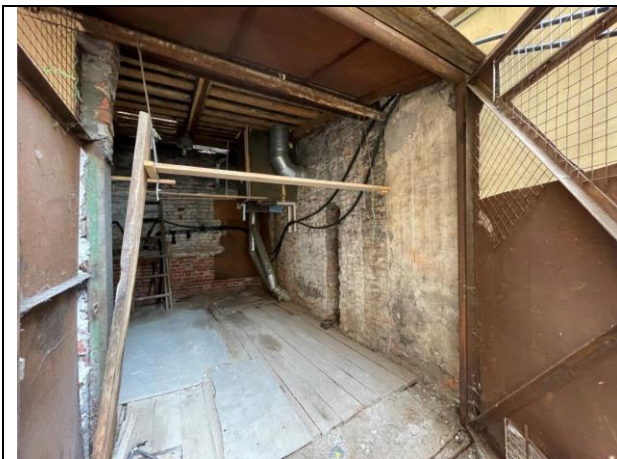
Фото 37. Типичное состояние Объекта оценки
