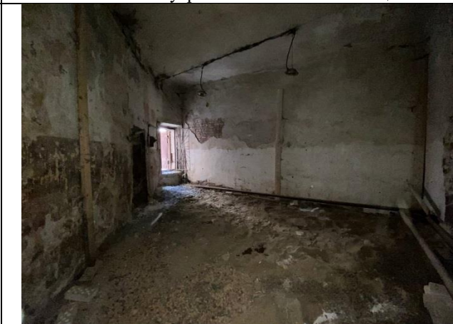
Фото № 8 – Внутреннее состояние помещения
