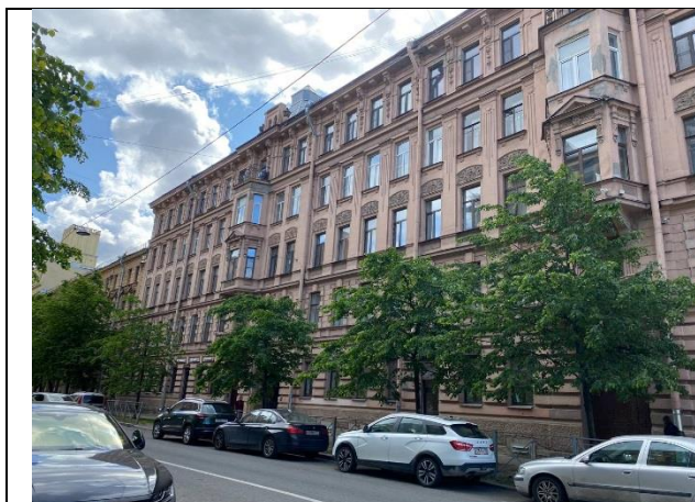
Фото № 1 – Здание, в котором находится Объект оценки
