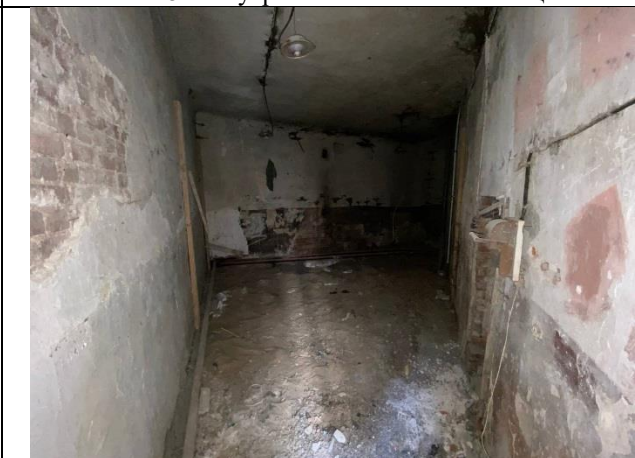
Фото № 10 – Внутреннее состояние помещения
