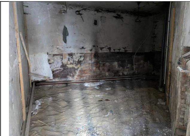
Фото № 6 – Внутреннее состояние помещения
