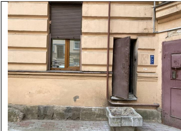
Фото № 5 – Вход в помещение со двора
