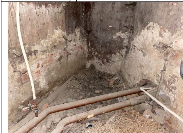
Фото № 11 – Внутреннее состояние помещения
