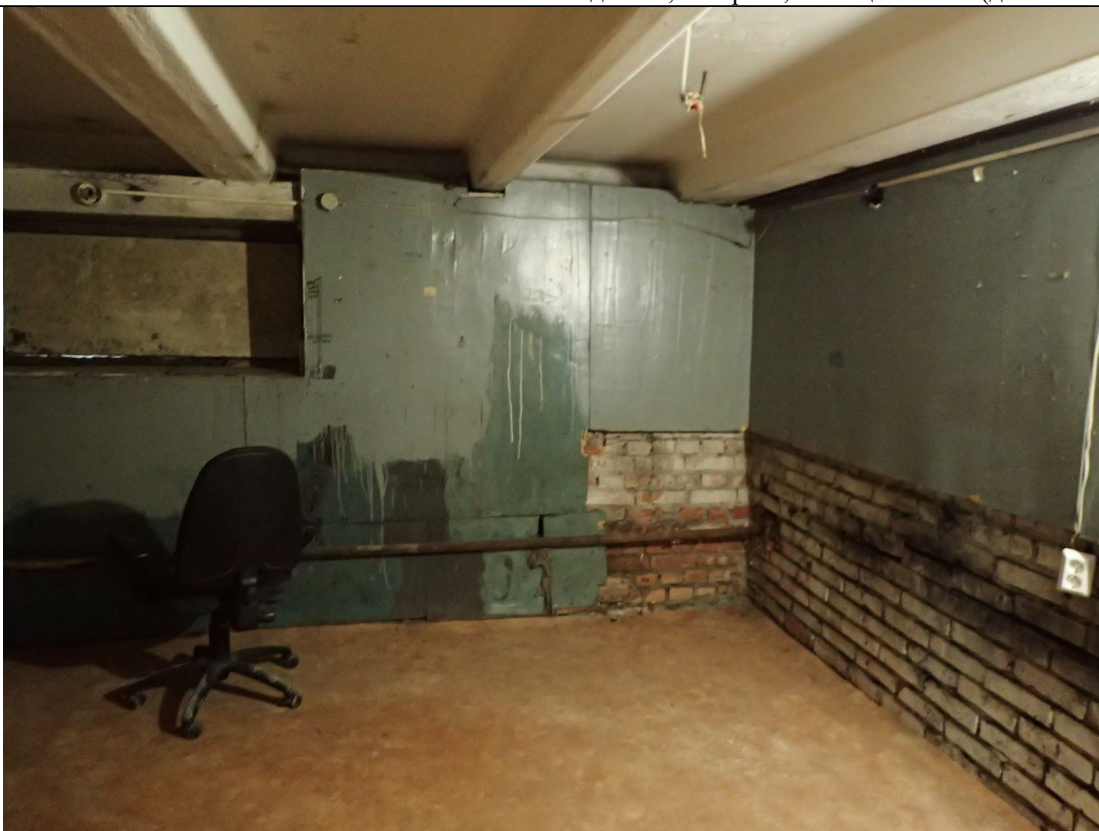
Описание: Вид внутри Объекта
