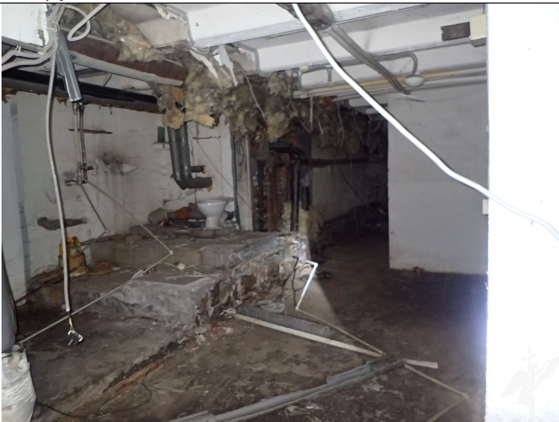
Описание: между ч.п.3, ч.п. 8 и ч.п. 9 Объекта демонтированы перегородки с дверным проемом.
