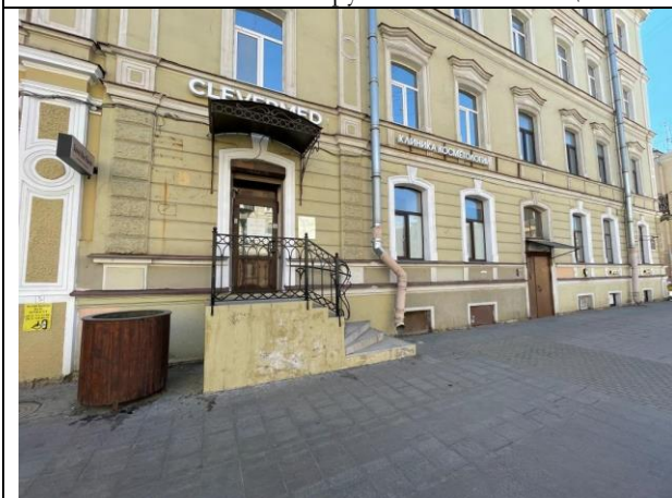
Фото 9. Вид здания Объекта оценки
