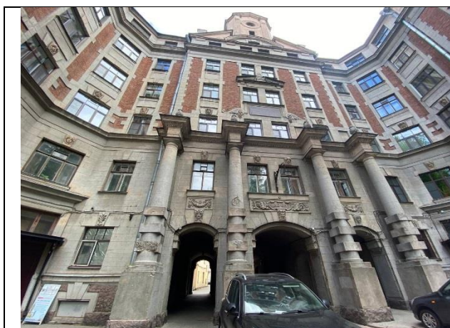
Фото № 1 – Здание, в котором находится Объект оценки
