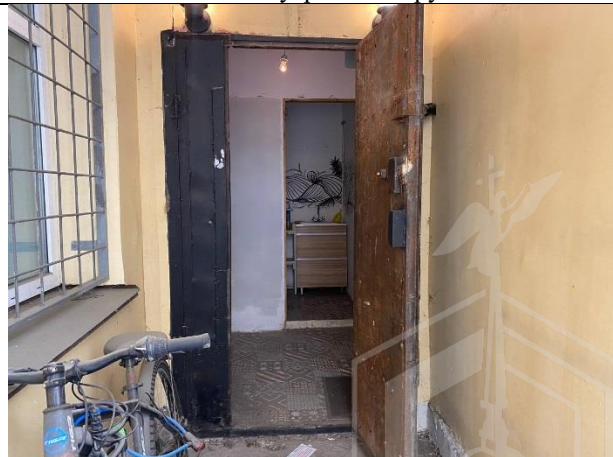
Фото № 6 – Внутреннее состояние помещения
