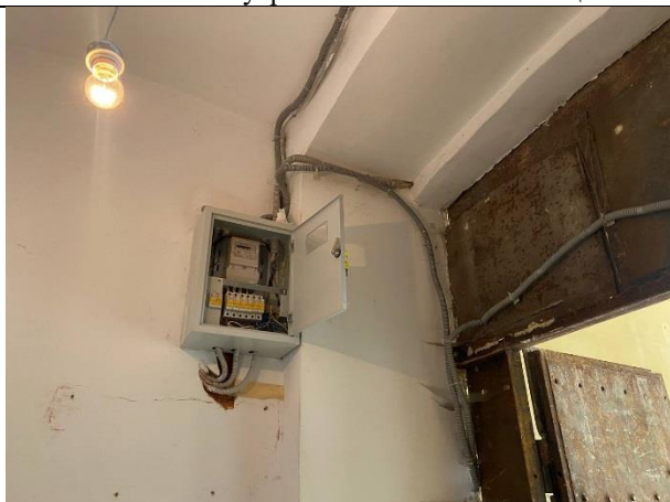
Фото № 13 – Внутреннее состояние помещения
