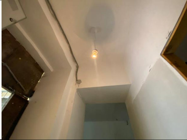
Фото № 7 – Внутреннее состояние помещения
