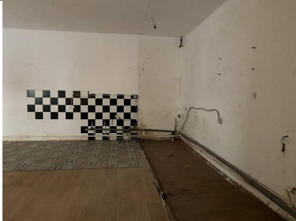
Фото № 9 – Внутреннее состояние помещения
