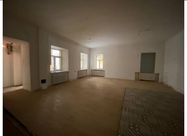
Фото № 10 – Внутреннее состояние помещения
