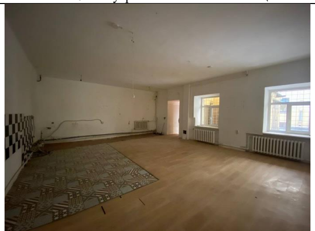
Фото № 12 – Внутреннее состояние помещения
