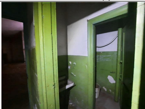
Фото № 13. Вид здания внутри
