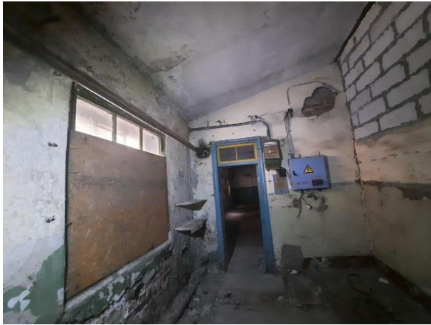
Фото № 17. Вид здания внутри
