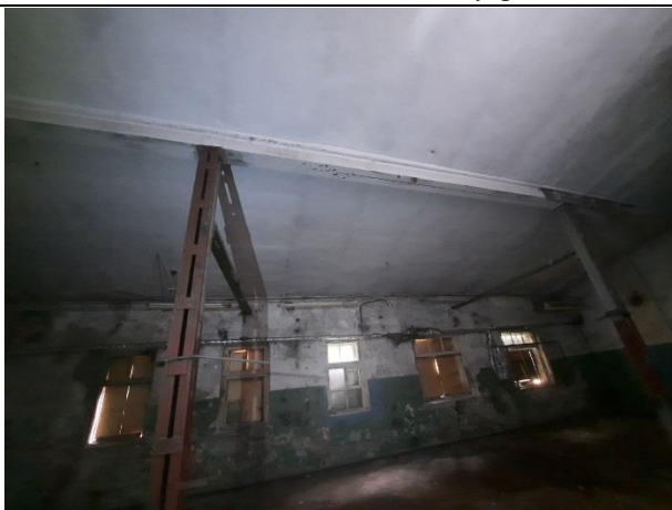
Фото № 19. Вид здания внутри
