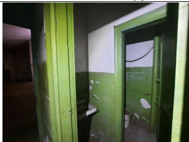
Фото № 13. Вид здания внутри
