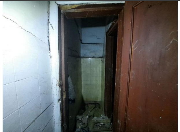
Фото № 10. Вид здания внутри
