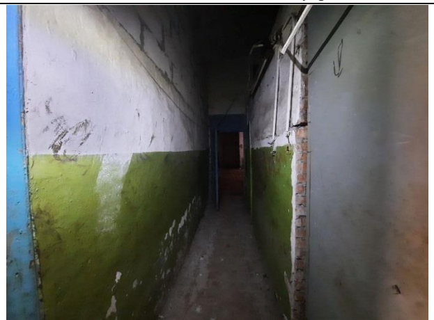
Фото № 12 Вид здания внутри
