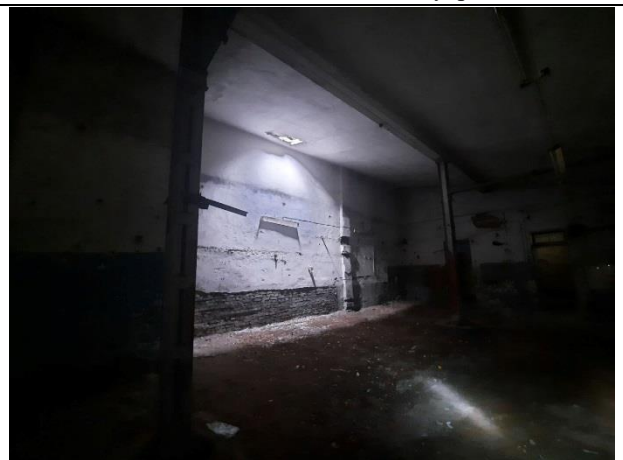
Фото № 20. Вид здания внутри
