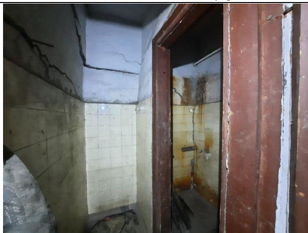
Фото № 11. Вид здания внутри
