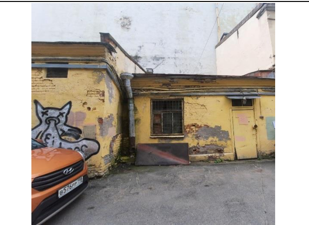
Фото № 6. Внешний вид здания
