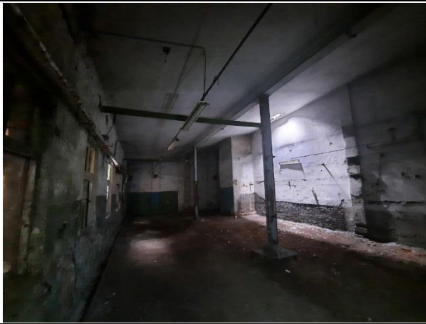
Фото № 15. Вид здания внутри
