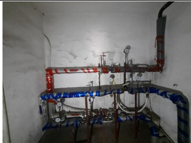
Фото № 9. Вид здания внутри
