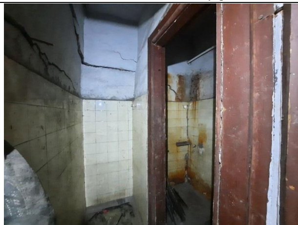
Фото № 11. Вид здания внутри
