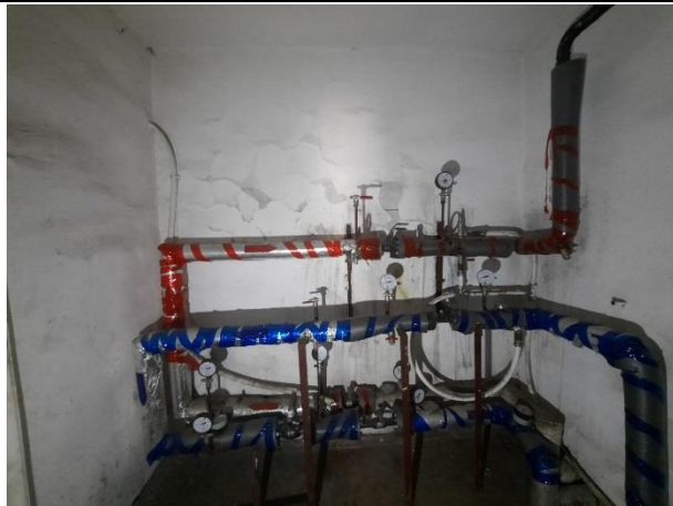
Фото № 9. Вид здания внутри
