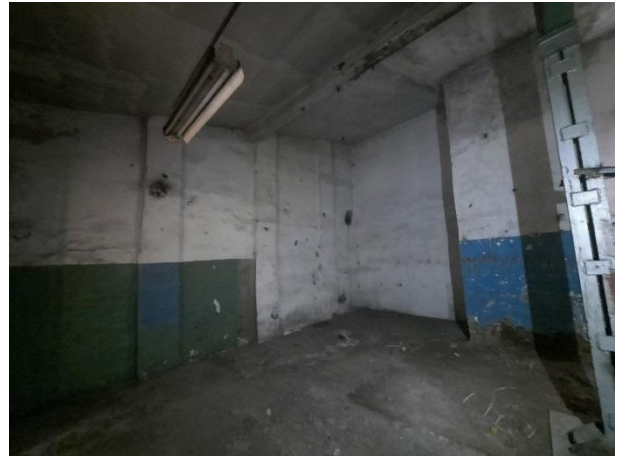
Фото № 18. Вид здания внутри
