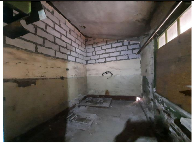
Фото № 16. Вид здания внутри
