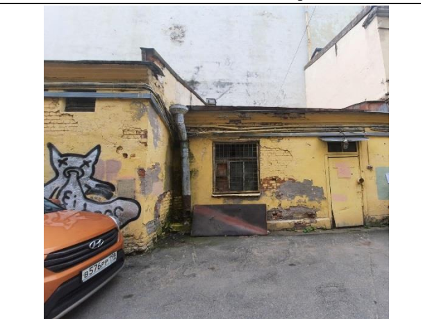
Фото № 6. Внешний вид здания
