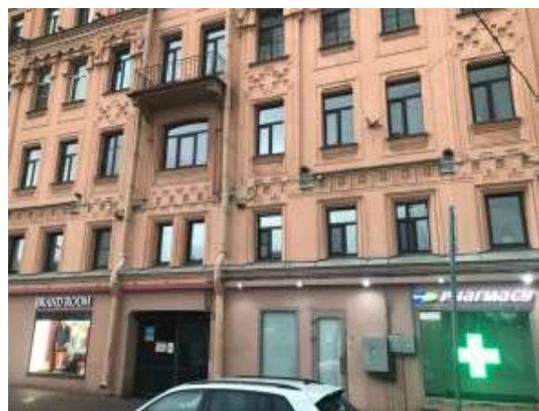
Фото 2. Вид здания Объекта оценки с улицы. Доступ Объекта оценки
