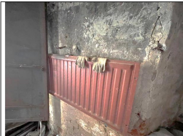
Фото 21. Типичное состояние Объекта оценки
