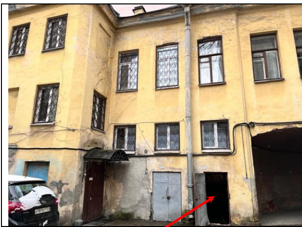
Фото 13. Вид здания расположения Объекта оценки, входная группа Объекта оценки
