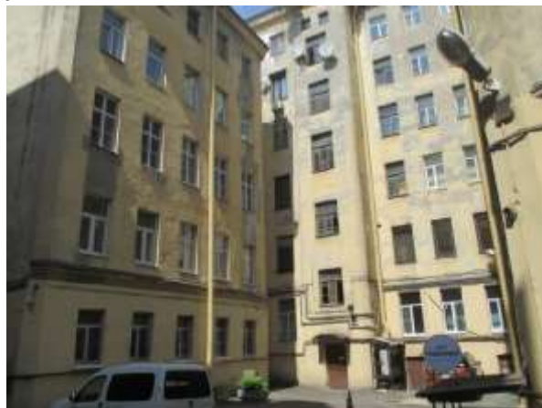
Фото 2. Вид здания Объекта оценки со двора
