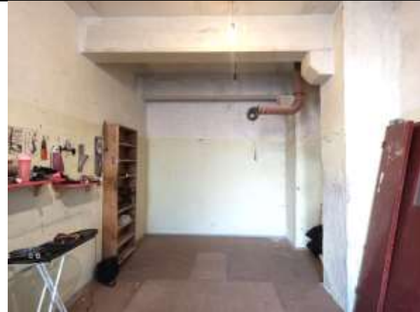
Фото 7. Внутреннее состояние Объекта оценки
