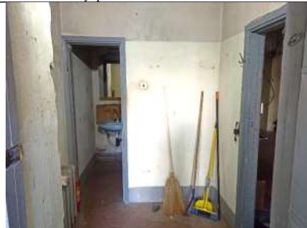
Фото 9. Внутреннее состояние Объекта оценки
