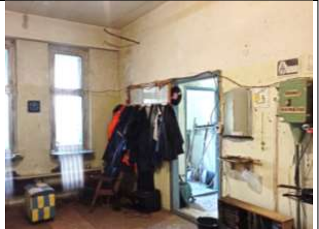
Фото 8. Внутреннее состояние Объекта оценки
