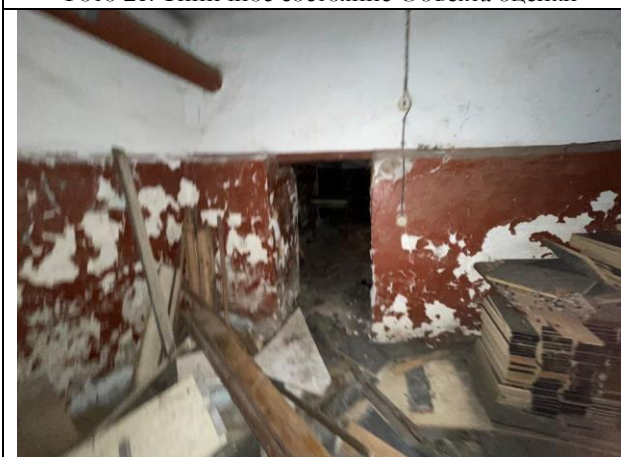
Фото 23. Типичное состояние Объекта оценки
