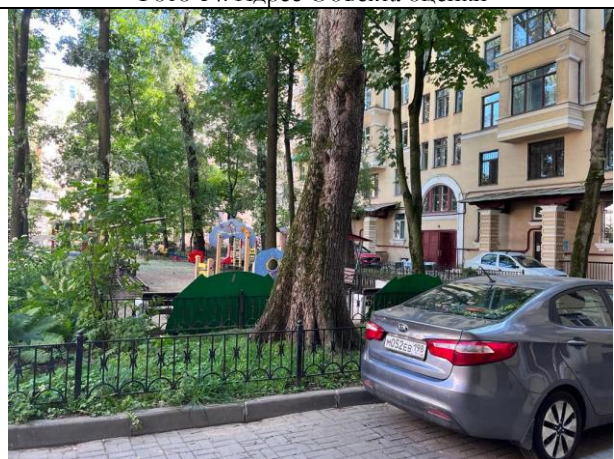
Фото 16. Вид здания расположения Объекта оценки
