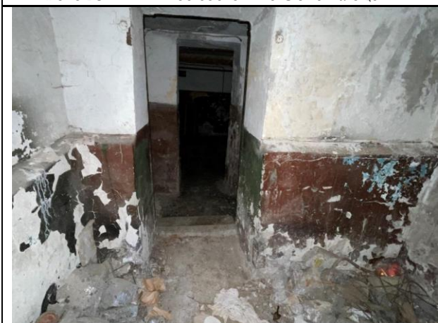
Фото 25. Типичное состояние Объекта оценки
