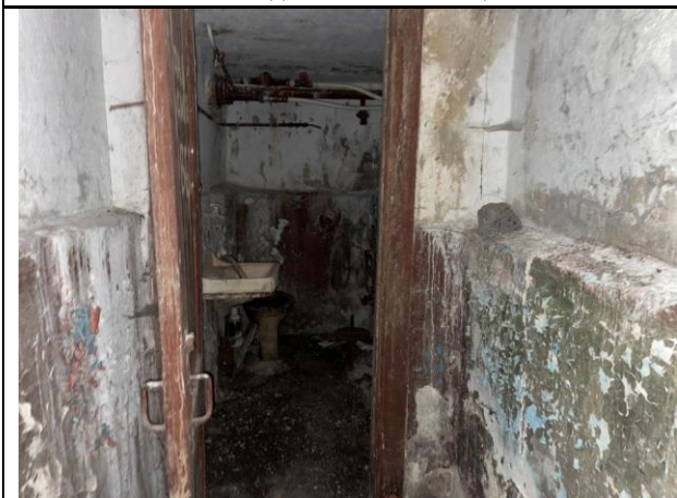
Фото 21. Типичное состояние Объекта оценки
