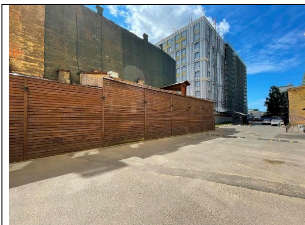
Фото 17. Вид здания расположения Объекта оценки
