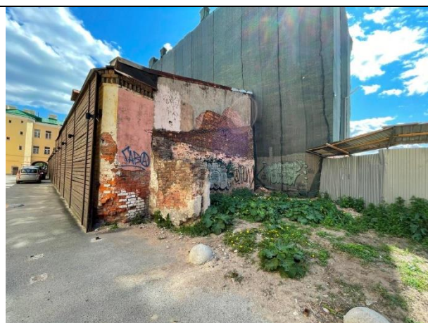
Фото 18. Вид здания расположения Объекта оценки
