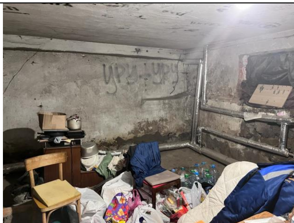
Фото 20. Типичное состояние Объекта оценки
