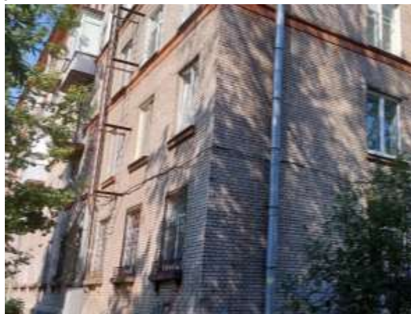
Фото 2. Вид здания, в котором расположен Объект оценки, со двора
