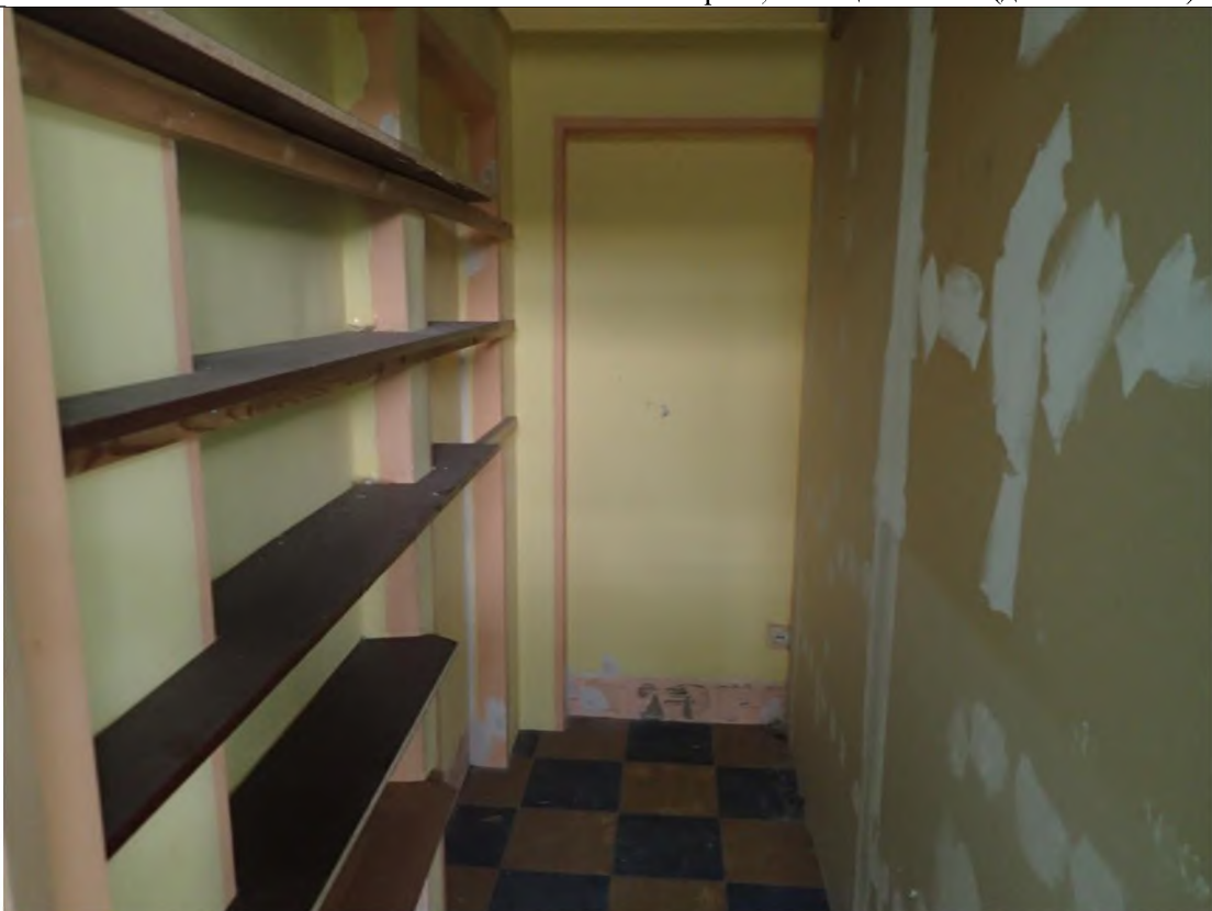
Описание: Вид внутри Объекта
