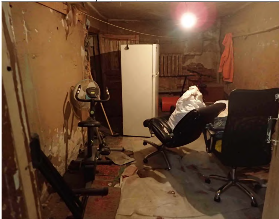
Описание: Вид внутри Объекта (ч.п. 8)
