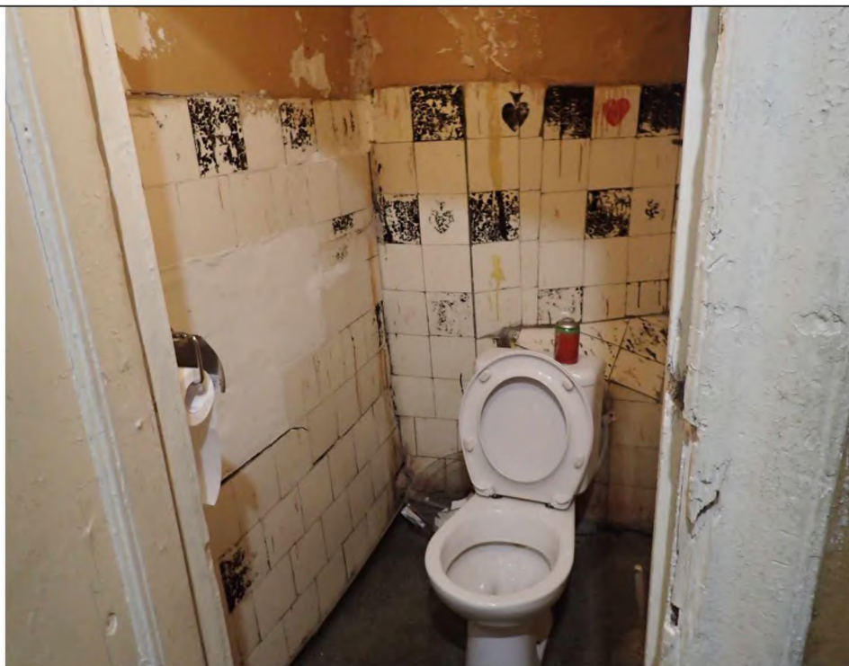
Описание: Вид внутри Объекта (ч.п. 4)
