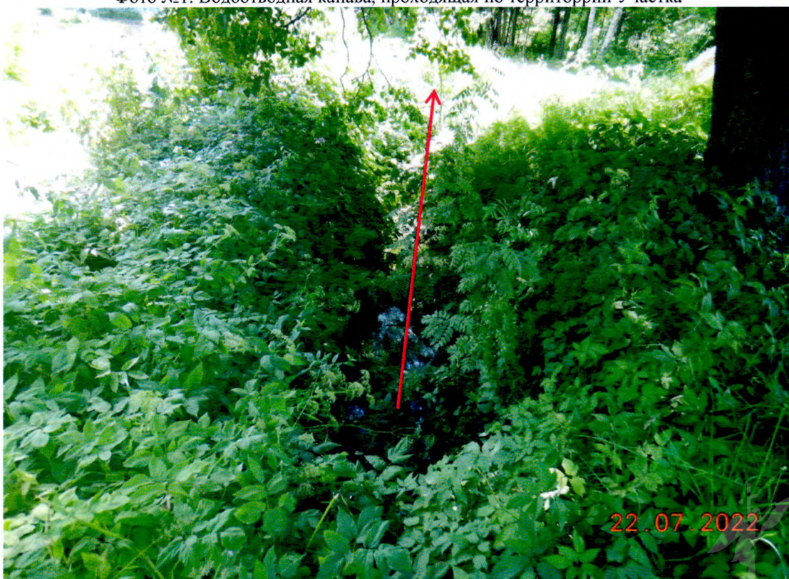
Фото №2. Водоотводная канава, проходящая по территории Участка
