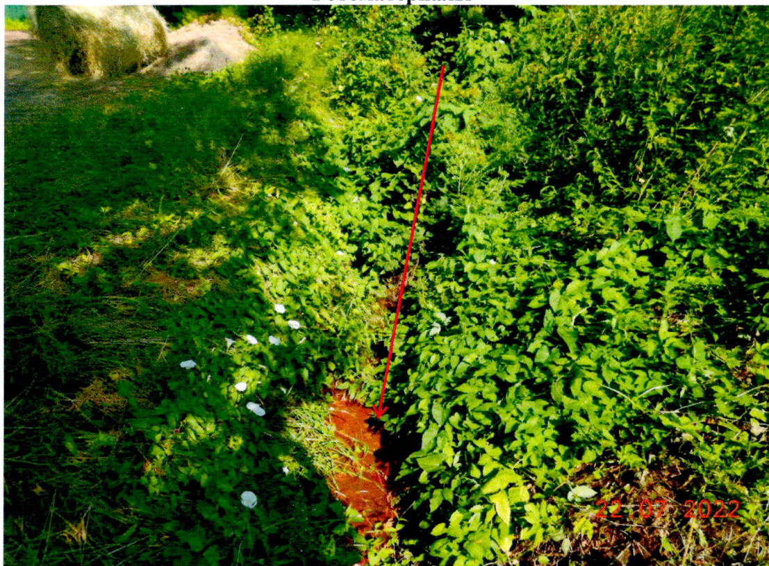
Фото №1. Водоотводная канава, проходящая по территории Участка
