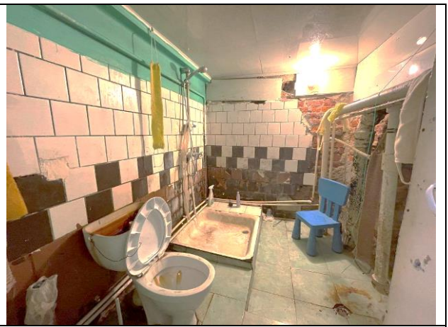
Фото 38. Типичное состояние Объекта оценки
