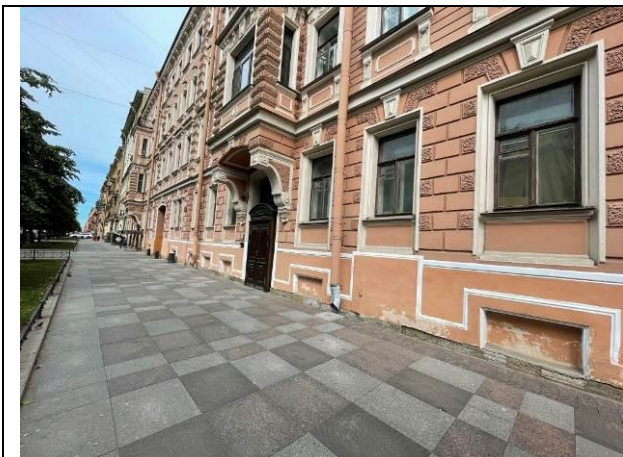
Фото 13. Вид здания расположения Объекта оценки
