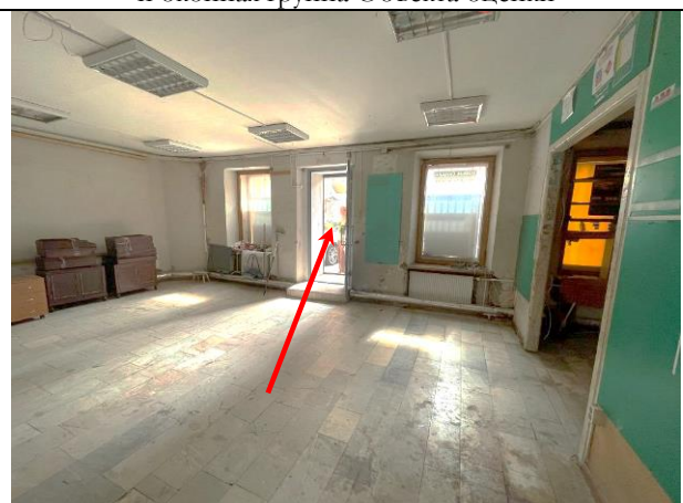
Фото 22. Входная и оконная группа Объекта оценки
