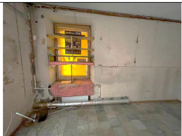
Фото 26. Типичное состояние Объекта оценки
