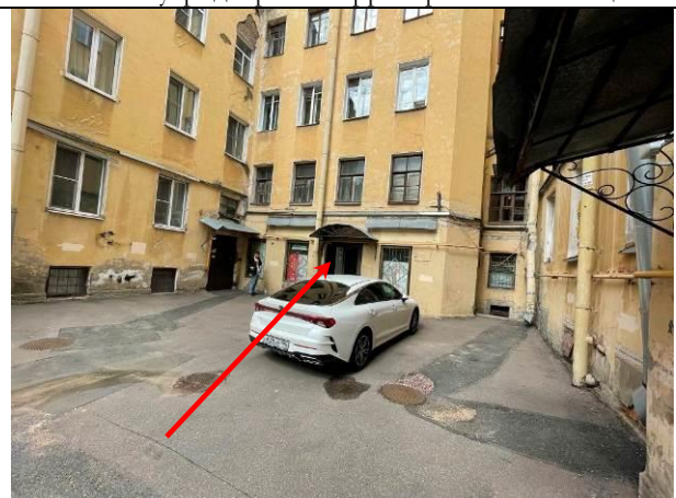
Фото 20. Вид расположения Объекта оценки, входная и оконная группа Объекта оценки
