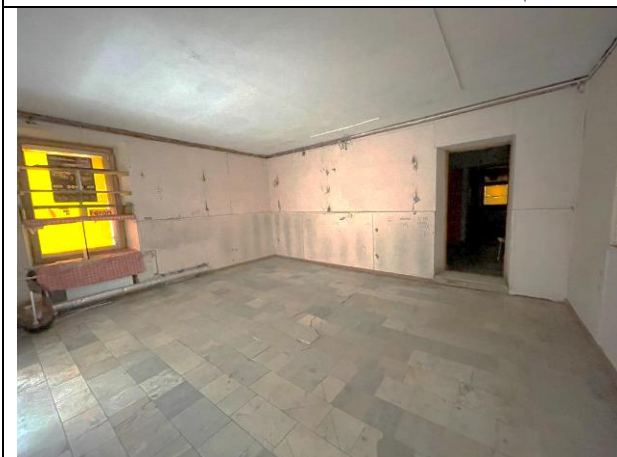
Фото 27. Типичное состояние Объекта оценки
