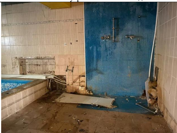
Фото № 13. Внутреннее состояние здания
