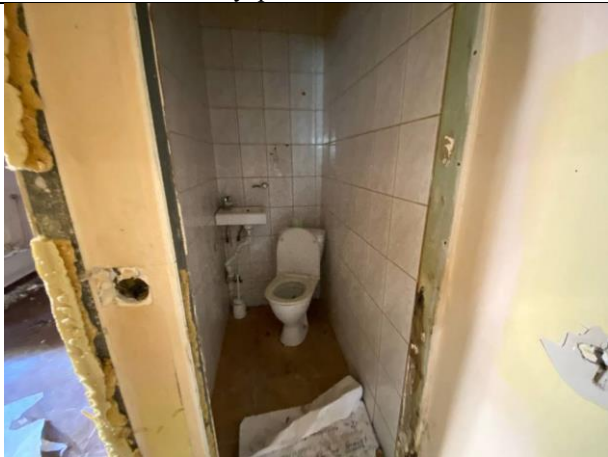
Фото № 11. Внутреннее состояние здания
