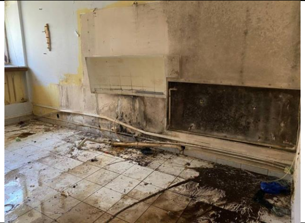
Фото № 10. Внутреннее состояние здания
