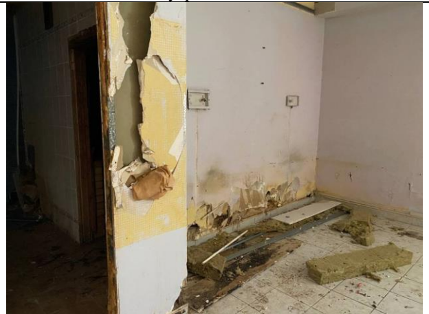
Фото № 12. Внутреннее состояние здания
