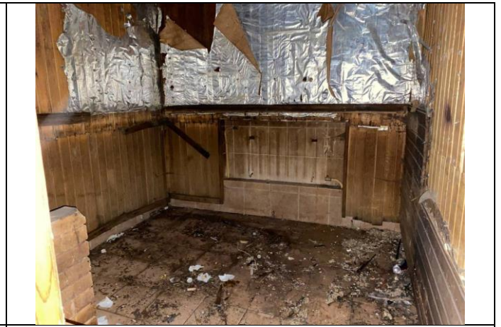
Фото № 16. Внутреннее состояние здания
