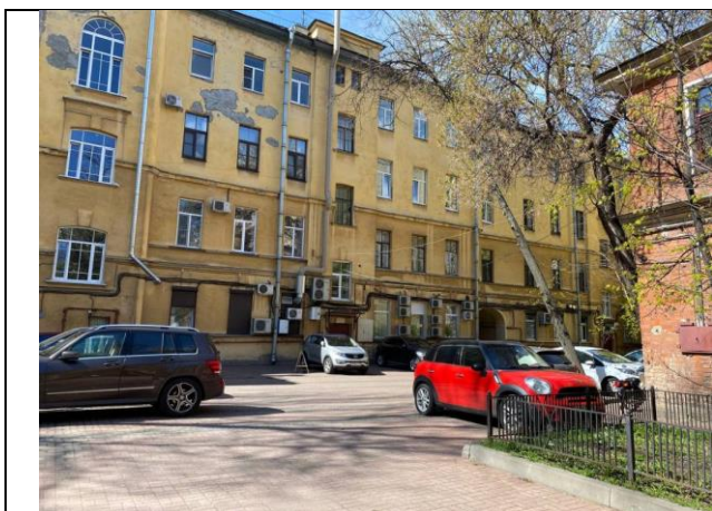
Фото № 1. Подъездные пути и окружение объекта
