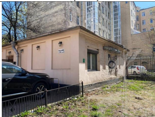
Фото № 6. Внешний вид здания
