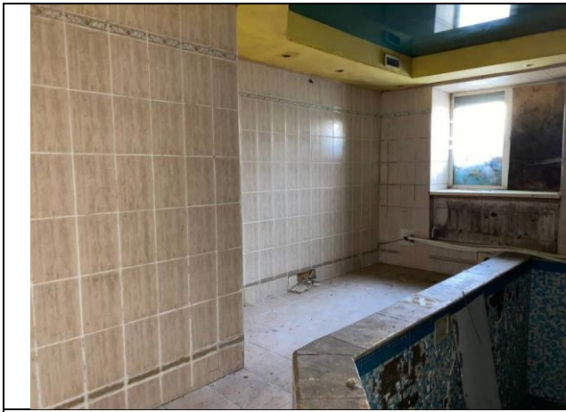
Фото № 15. Внутреннее состояние здания
