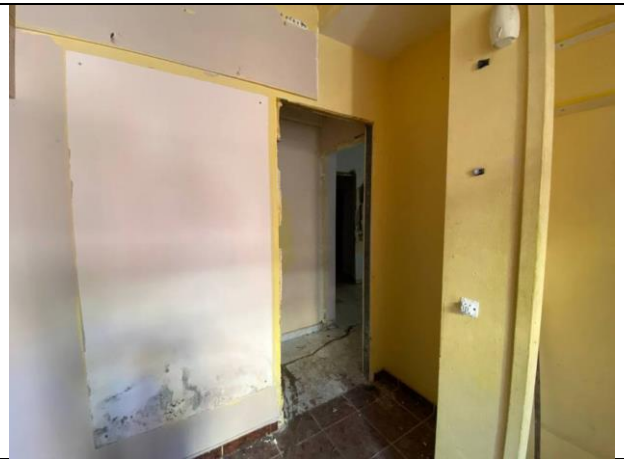
Фото № 8. Внутреннее состояние здания
