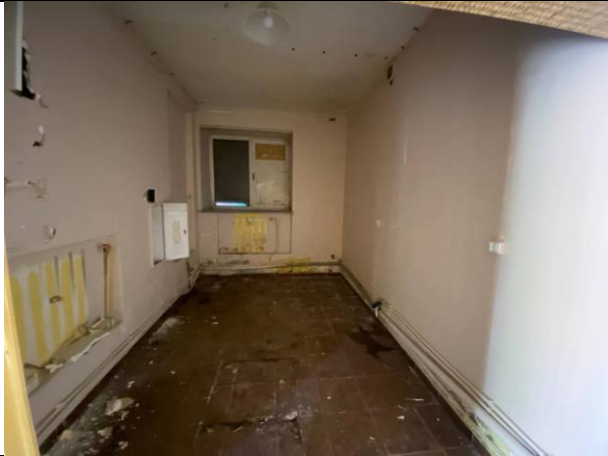
Фото № 9. Внутреннее состояние здания
