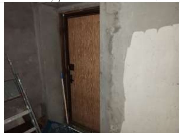
Фото 16. Внутреннее состояние Объекта оценки
