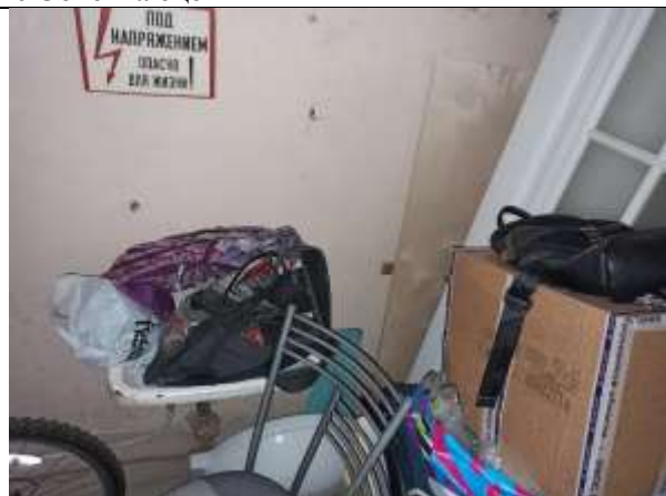
Фото 10. Внутреннее состояние Объекта оценки
