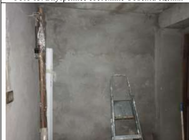
Фото 15. Внутреннее состояние Объекта оценки
