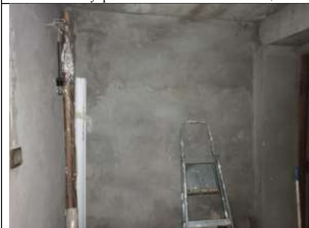
Фото 15. Внутреннее состояние Объекта оценки
