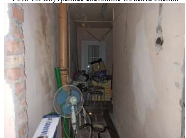
Фото 18. Внутреннее состояние Объекта оценки
