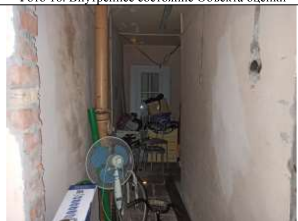
Фото 18. Внутреннее состояние Объекта оценки
