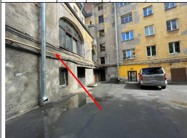
Фото 23. Вид расположения здания Объекта оценки
