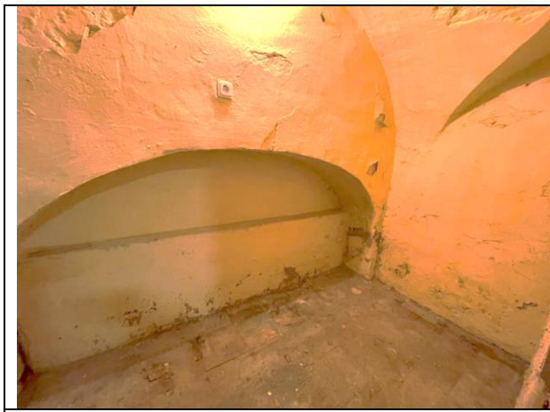
Фото 29. Типичное состояние Объекта оценки
