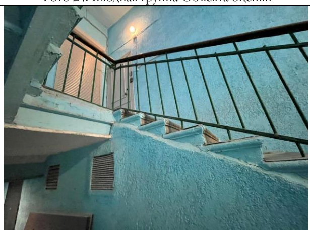
Фото 26. Лестничный проём Объекта оценки
