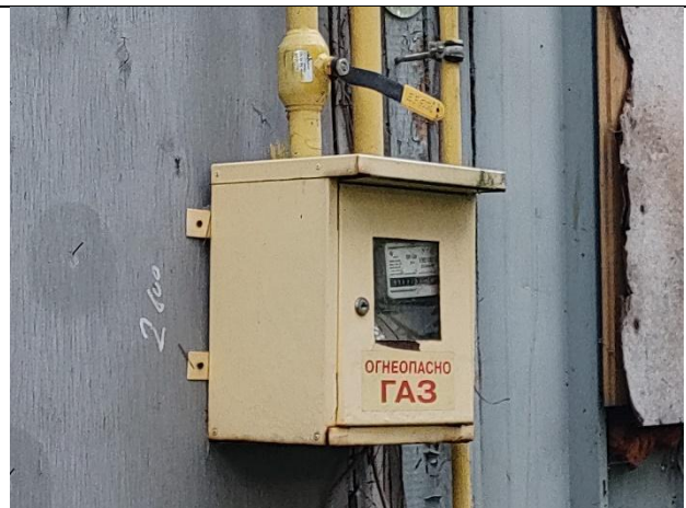
Фото 14. Вид Объекта оценки (ГРП на территории)
