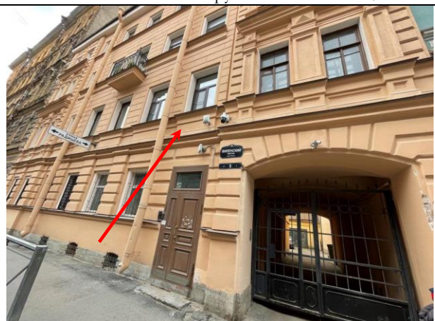
Фото 14. Вид здания Объекта оценки
