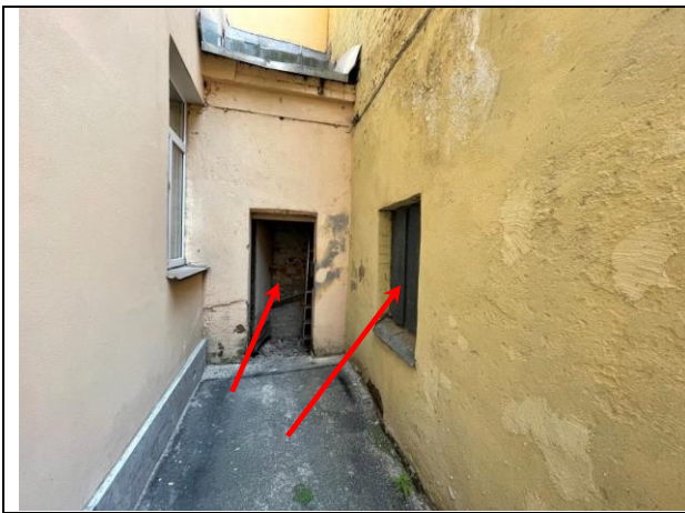
Фото 19. Входная и оконная группа Объекта оценки
