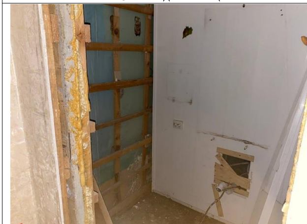
Фото № 7 – Внутреннее состояние помещения
