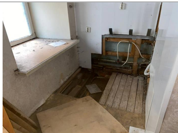
Фото № 6 – Внутреннее состояние помещения
