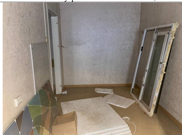
Фото № 8 – Внутреннее состояние помещения
