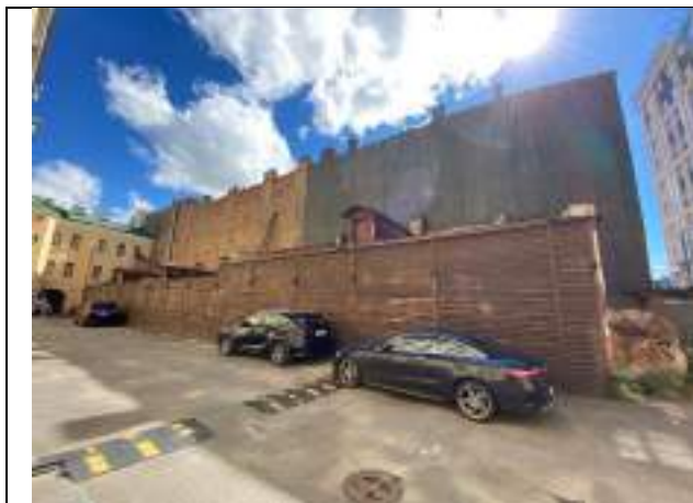
Фото № 7 – Внешнее состояние
