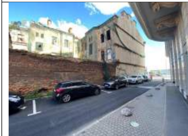
Фото № 9 – Внешнее состояние
