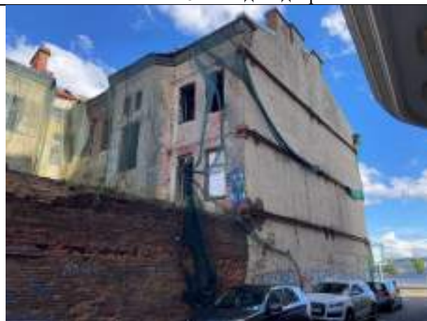
Фото № 10 – Внешнее состояние
