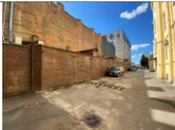
Фото № 6 – Внешнее состояние
