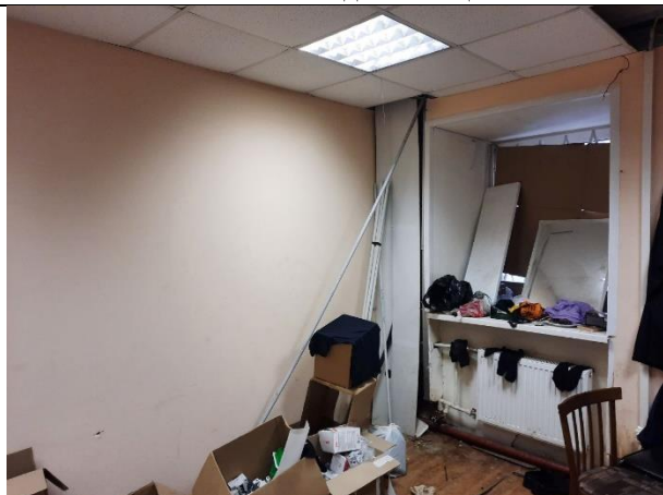
Фото № 9 – Внутреннее состояние помещения
