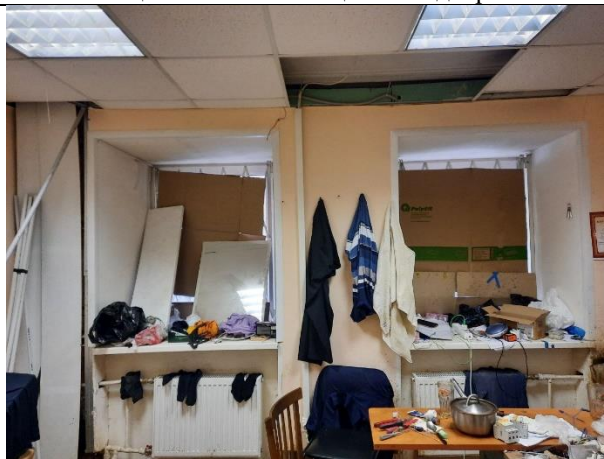
Фото № 8 – Внутреннее состояние помещения
