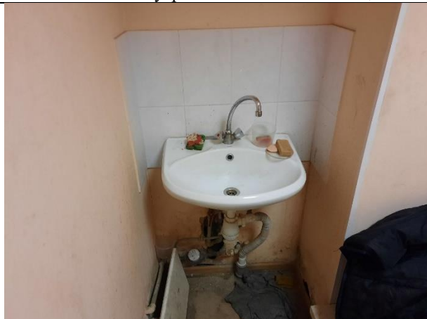
Фото № 13 – Внутреннее состояние помещения
