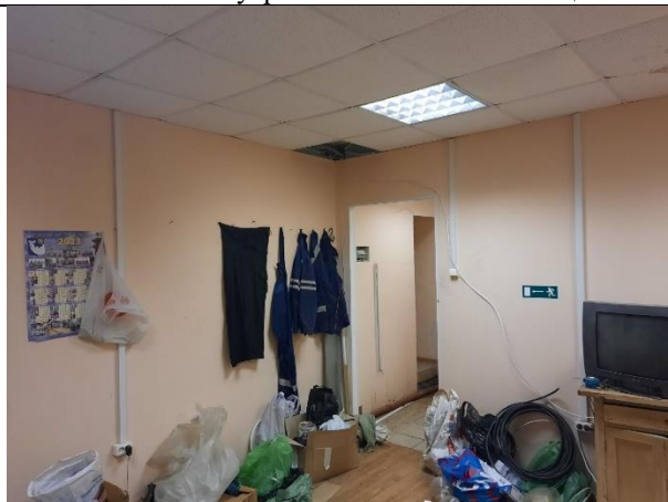
Фото № 10 – Внутреннее состояние помещения
