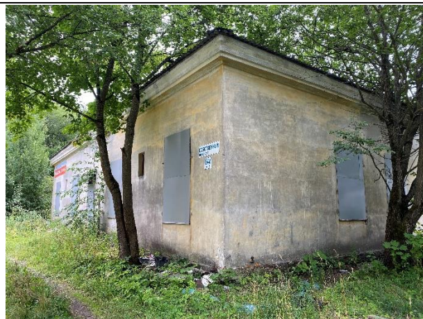
Фото № 6. Внешний вид здания
