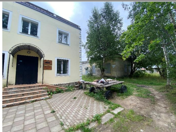
Фото № 2. Подъездные пути и окружение объекта
