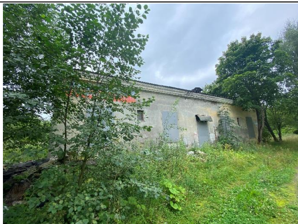
Фото № 5. Внешний вид здания и земельного участка
