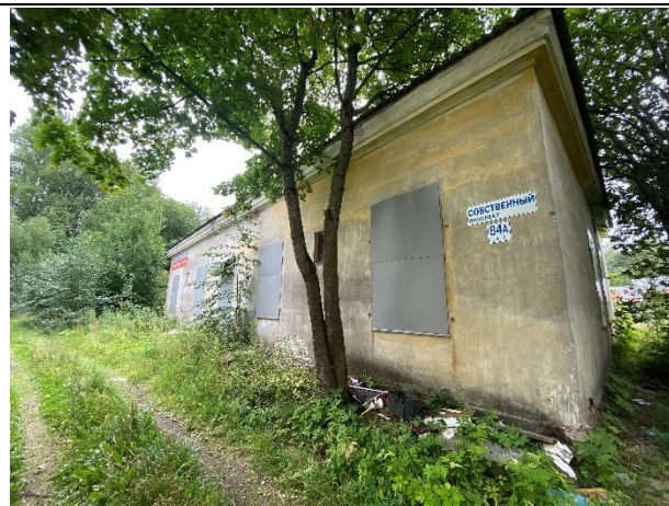
Фото № 8. Внешний вид здания и земельного участка
