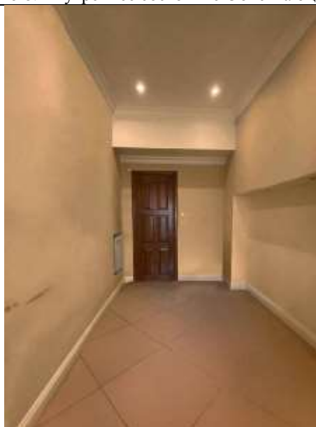
Фото 10. Внутреннее состояние Объекта оценки
