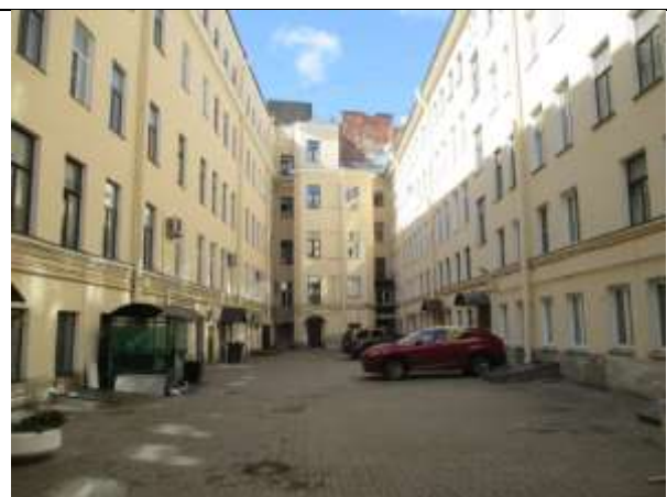
Фото 4. Вид здания, в котором расположен Объект оценки. Дворовая территория
