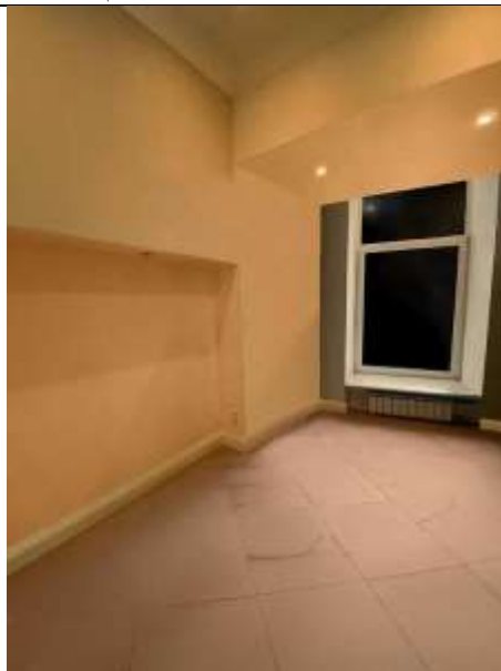
Фото 8. Внутреннее состояние Объекта оценки
