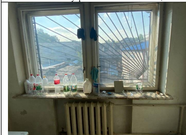
Фото № 19 – Внутреннее состояние помещения
