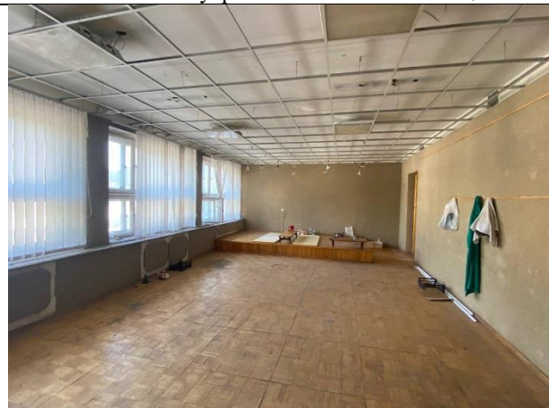
Фото № 12 – Внутреннее состояние помещения
