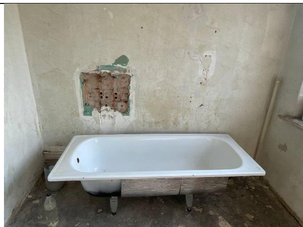
Фото № 18 – Внутреннее состояние помещения
