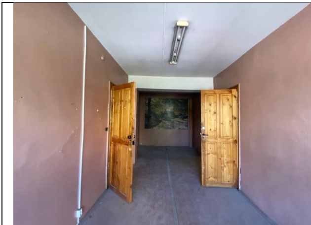
Фото № 9 – Внутреннее состояние помещения
