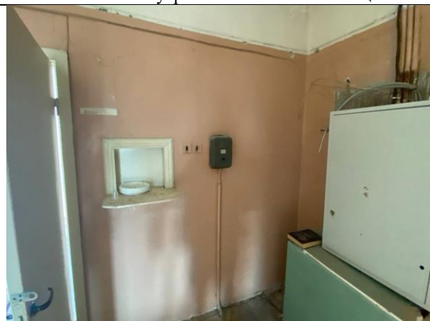
Фото № 14 – Внутреннее состояние помещения
