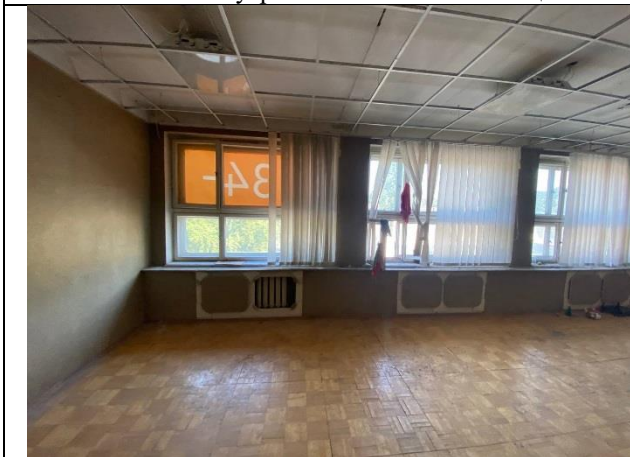
Фото № 11 – Внутреннее состояние помещения
