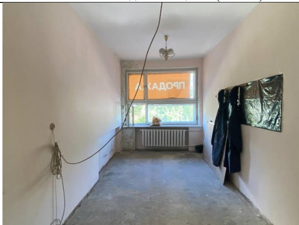
Фото № 7 – Внутреннее состояние помещения
