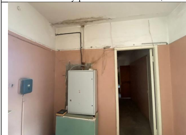
Фото № 13 – Внутреннее состояние помещения
