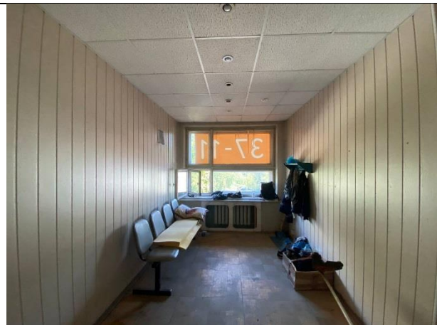
Фото № 10 – Внутреннее состояние помещения
