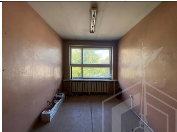
Фото № 8 – Внутреннее состояние помещения
