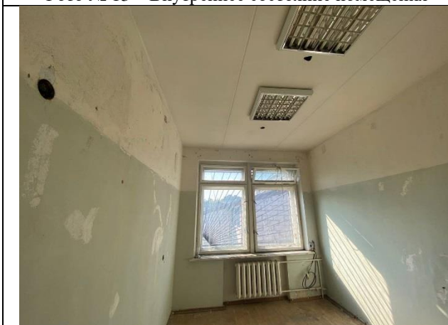
Фото № 15 – Внутреннее состояние помещения
