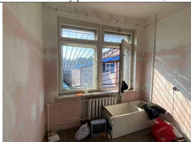
Фото № 20 – Внутреннее состояние помещения
