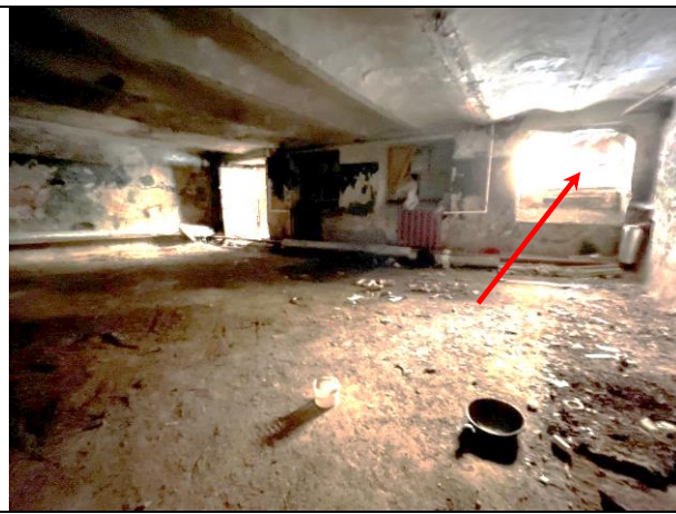
Фото 29. Типичное состояние Объекта оценки, оконная группа Объекта оценки
