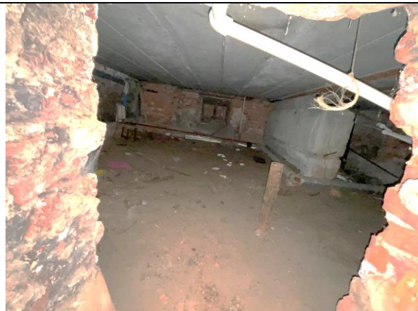
Фото 35. Типичное состояние Объекта оценки
