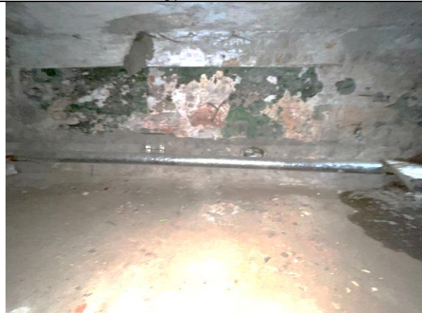
Фото 31. Типичное состояние Объекта оценки
