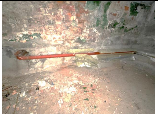
Фото 32. Типичное состояние Объекта оценки
