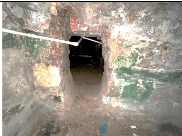
Фото 33. Типичное состояние Объекта оценки
