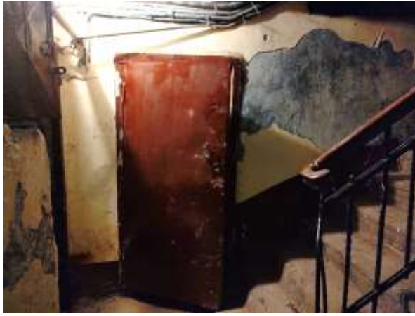
Фото 7. Отдельный вход Объекта оценки
