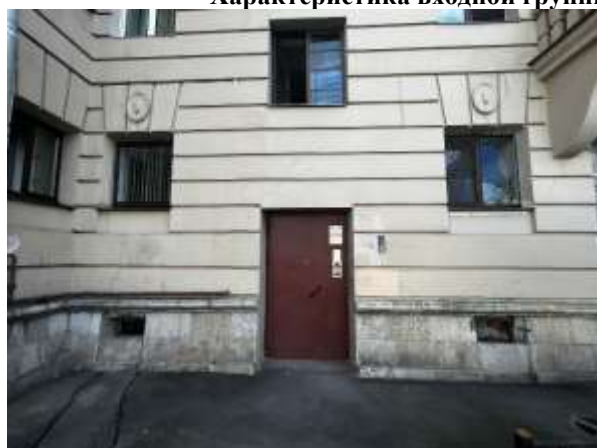
Фото 5. Общий вход с улицы
