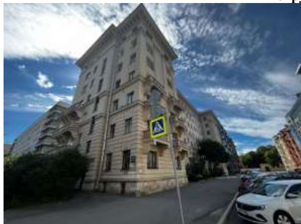
Фото 1. Вид здания, в котором расположен Объект оценки с улицы
