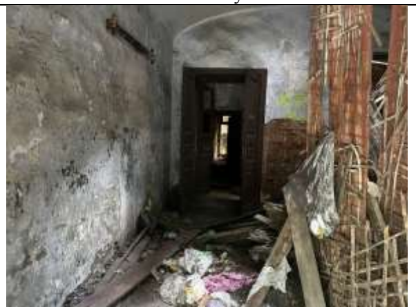
Фото 16. Внутреннее состояние Объекта
