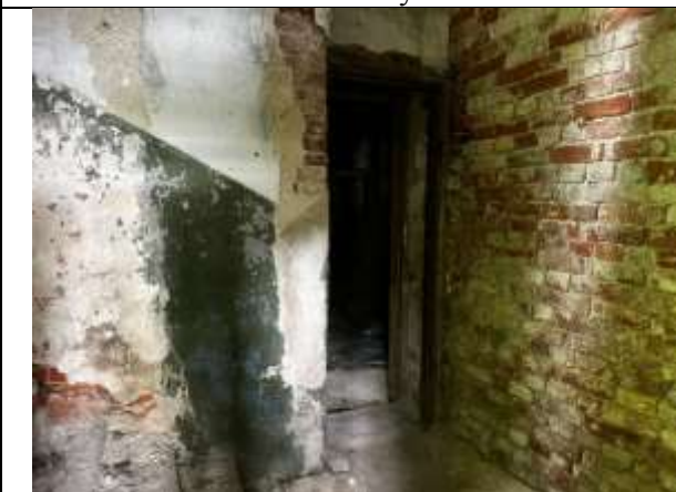
Фото 15. Внутреннее состояние Объекта
