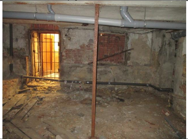
Фото № 12 – Внутреннее состояние помещения
