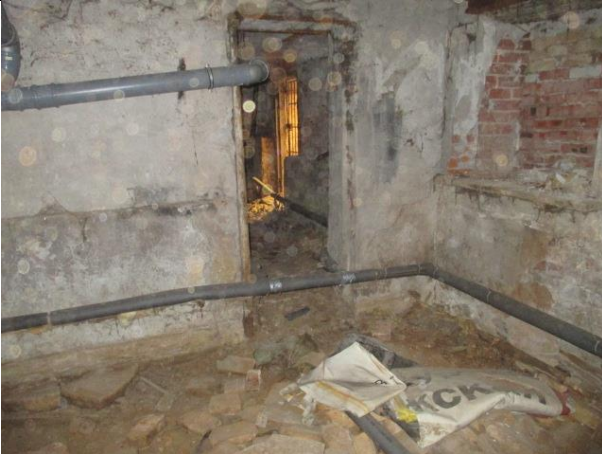
Фото № 9 – Внутреннее состояние помещения
