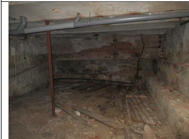
Фото № 5 – Внутреннее состояние помещения
