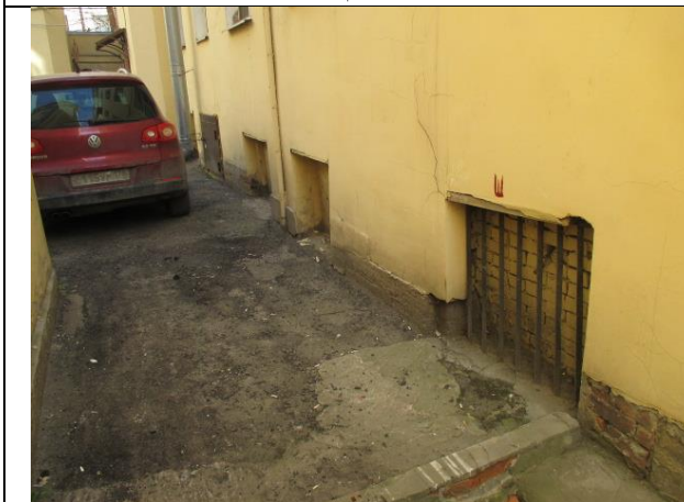
Фото № 3 – Окна в помещении (заложены)
