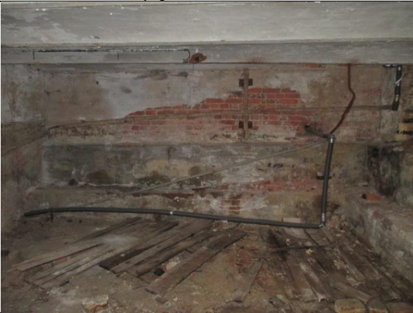
Фото № 11 – Внутреннее состояние помещения
