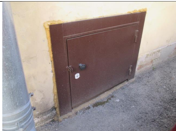
Фото № 6 – Вход в помещение через переоборудованное окно
