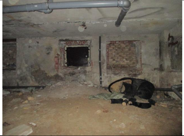
Фото № 8 – Внутреннее состояние помещения
