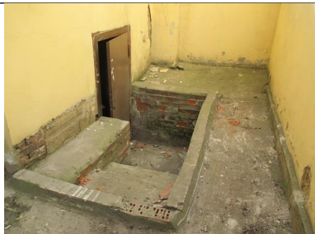
Фото № 4 – Вход в помещение
