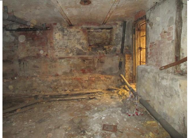
Фото № 10 – Внутреннее состояние помещения
