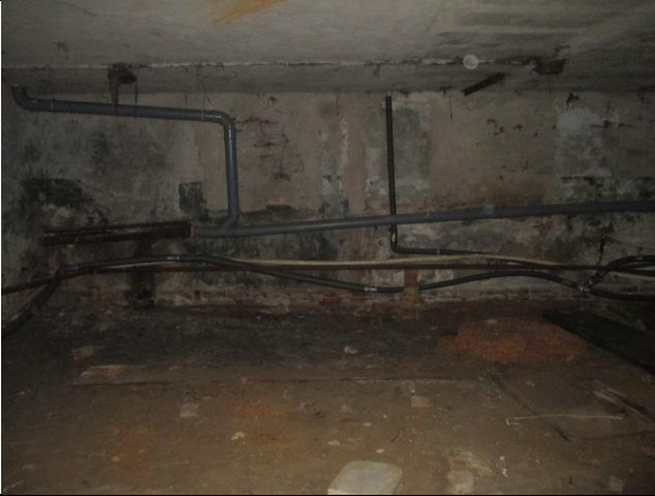
Фото № 7 – Внутреннее состояние помещения
