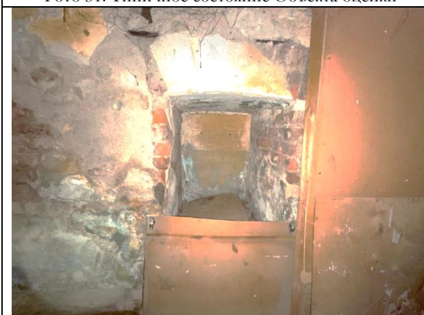
Фото 33. Типичное состояние Объекта оценки
