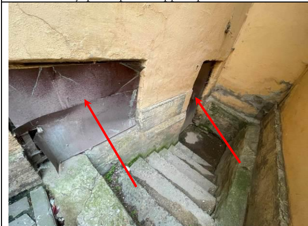
Фото 21. Входная и оконная группа Объекта оценки со стороны двора
