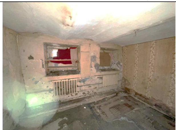
Фото 30. Типичное состояние Объекта оценки
