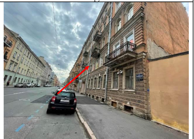
Фото 16. Вид здания Объекта оценки
