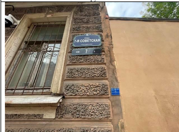
Фото 15. Адрес Объекта оценки
