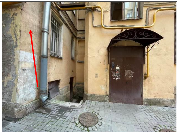
Фото 20. Вид здания расположения Объекта оценки
