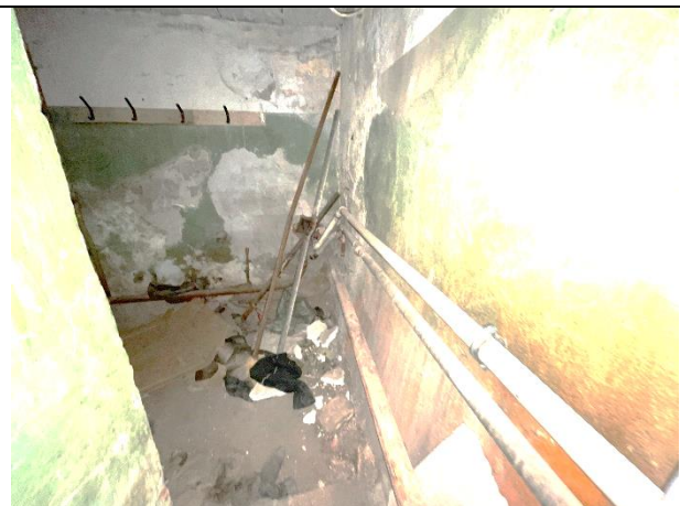
Фото 36. Типичное состояние Объекта оценки
